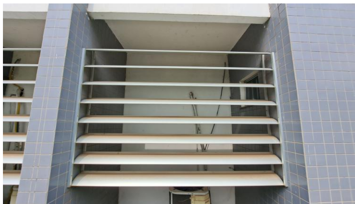
Figura 37 – Brise soleil metálico de alumínio, tipo Aeroscreen.
