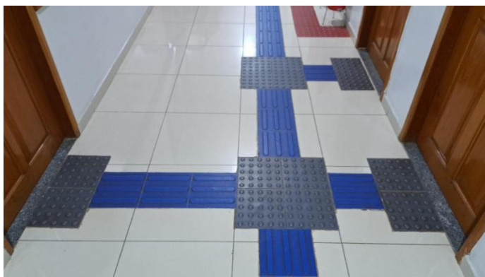
Figura 29 – Padrão de piso pedotátil da Câmara Municipal de Marabá.
