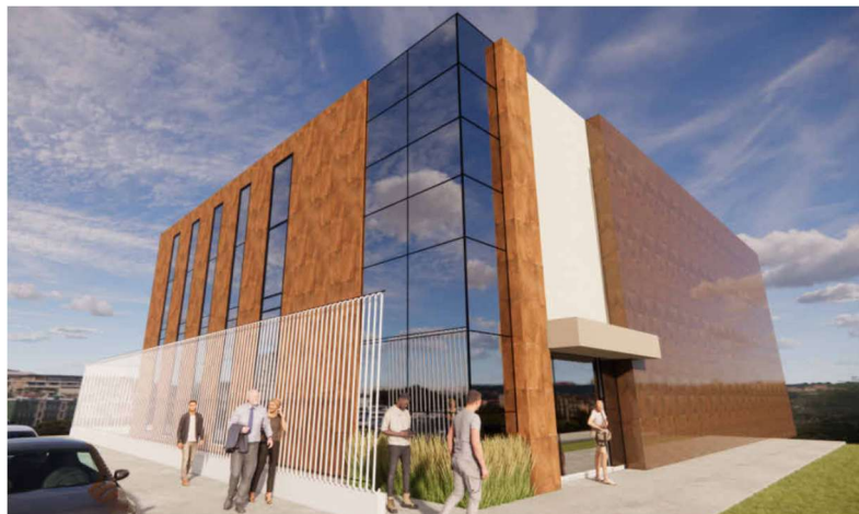
Figura 8 – Pele de Vidro da fachada, em vidro refletivo.
