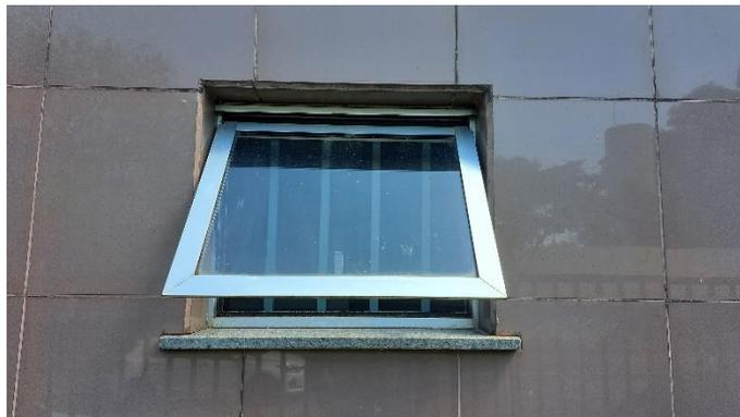
Figura 7 - Janela Basculante.
