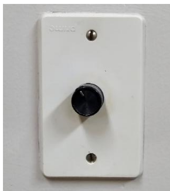
Figura 49 – Caixa 4x2" com tampa cega e potenciômetro com knob, instalada na parede.
