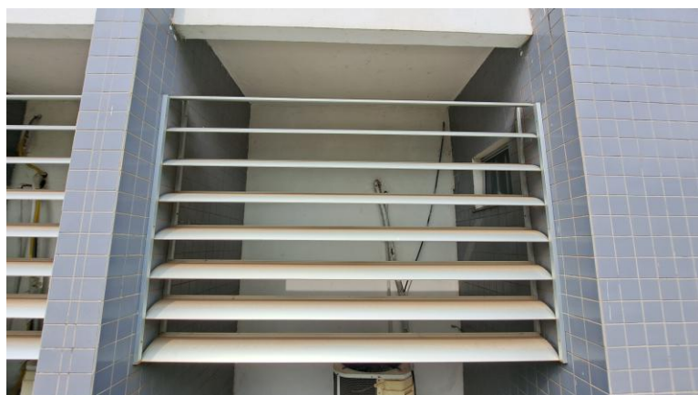
Figura 51 – Brise soleil metálico de alumínio, tipo Aeroscreen – vista externa.
