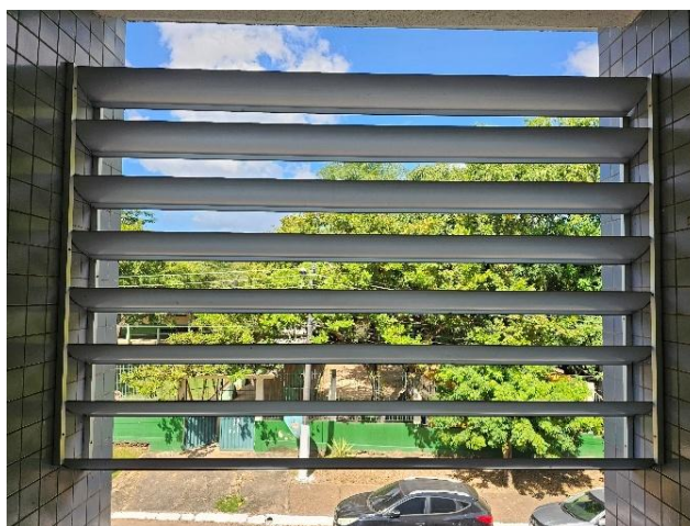
Figura 52 – Brise soleil metálico de alumínio, tipo Aeroscreen – vista interna.
