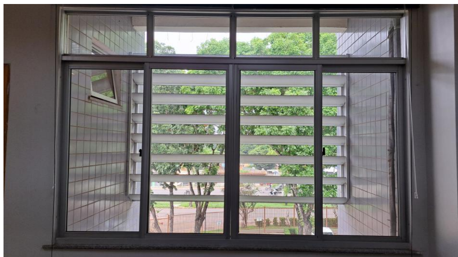
Figura 6 - Janela de alumínio de correr.
