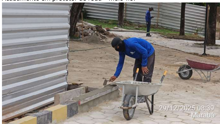
Acabamento em protetor de roda – meio-fio:
