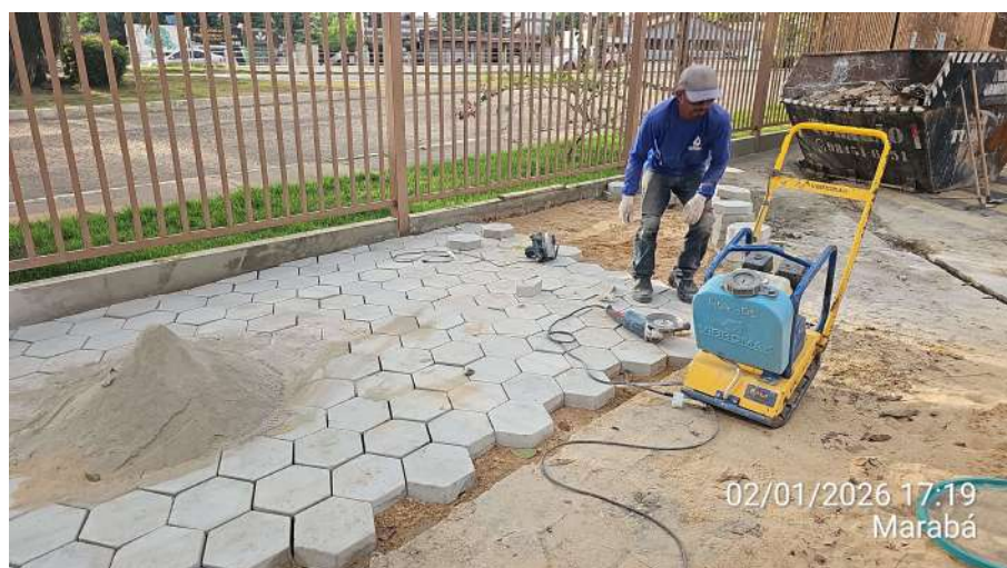
Compactação de blocos intertravados com placa vibratória:
