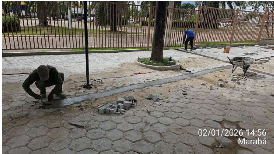
Acabamentos de junta entre pisos com argamassa:
