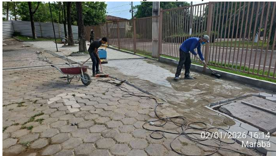
Espalhamento de mistura de areia e argamassa para rejuntamento dos blocos:
