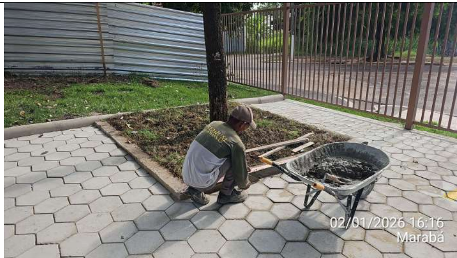
Espalhamento de mistura de areia e argamassa para rejuntamento dos blocos:
