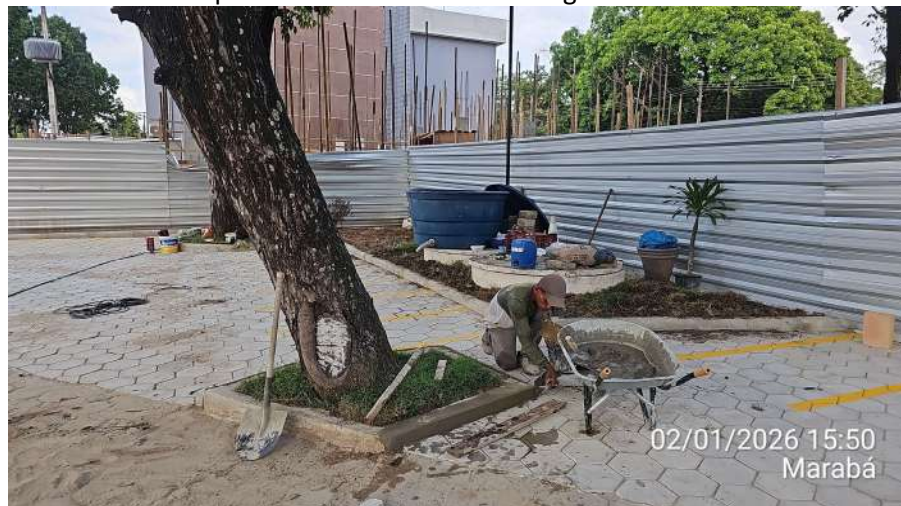
Acabamentos de protetores de árvores com argamassa:
