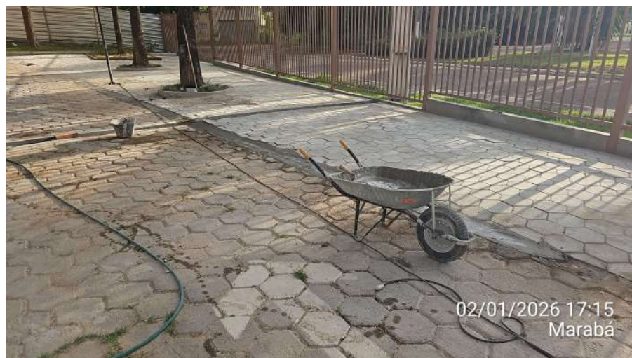
Acabamentos de protetores de árvores com argamassa:
