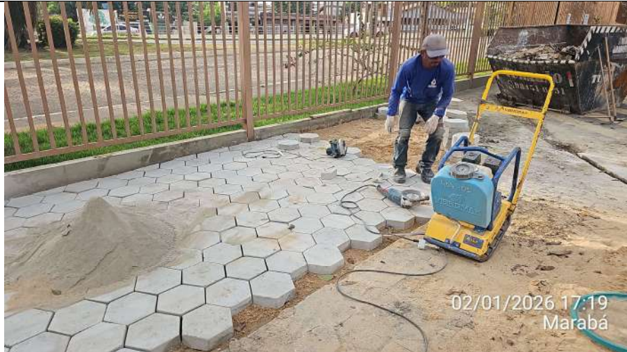
Compactação de blocos intertravados com placa vibratória:
