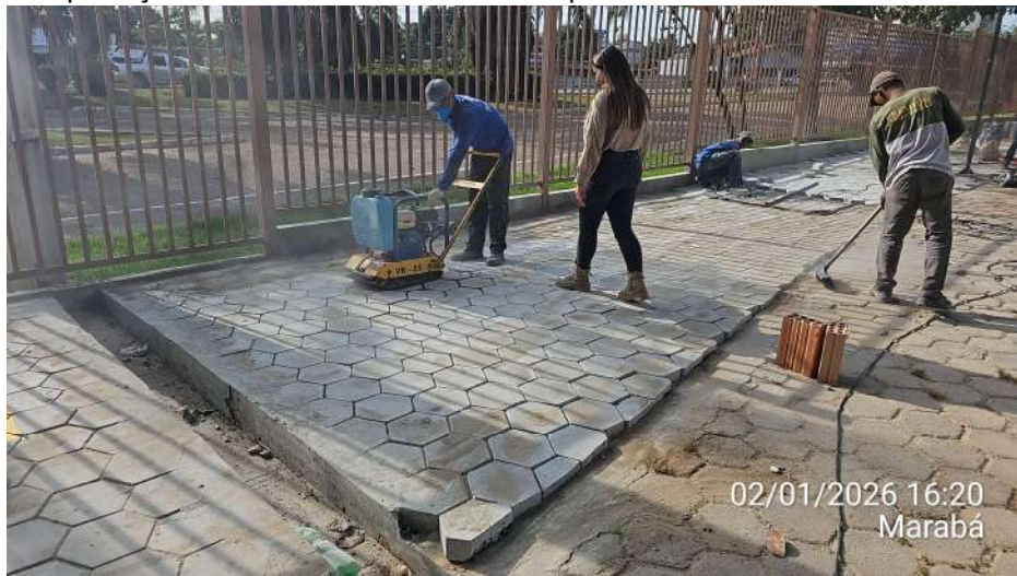
Compactação de blocos intertravados com placa vibratória:
