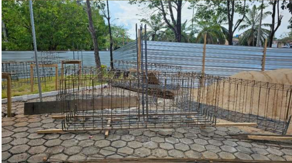
Locação das estacas da obra do Anexo 02:
