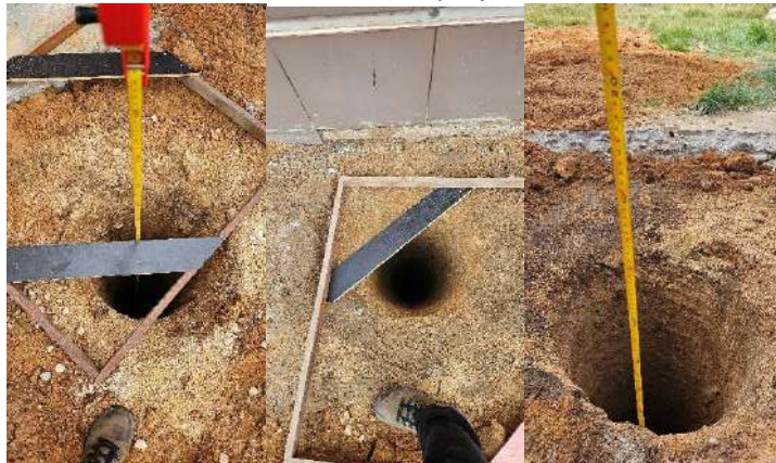
Conferência das cotas dos furos, conforme projeto estrutural:
