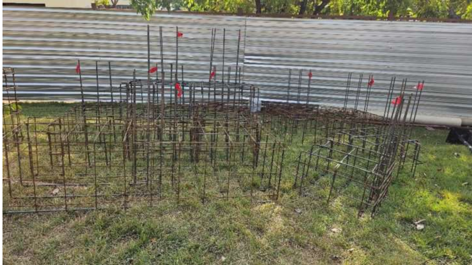
Início da armação das vigas baldrame da obra do Anexo 01:
