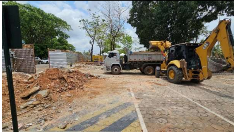
Retirada de grade e fechamento com tapume da parte frontal do Anexo 01:
