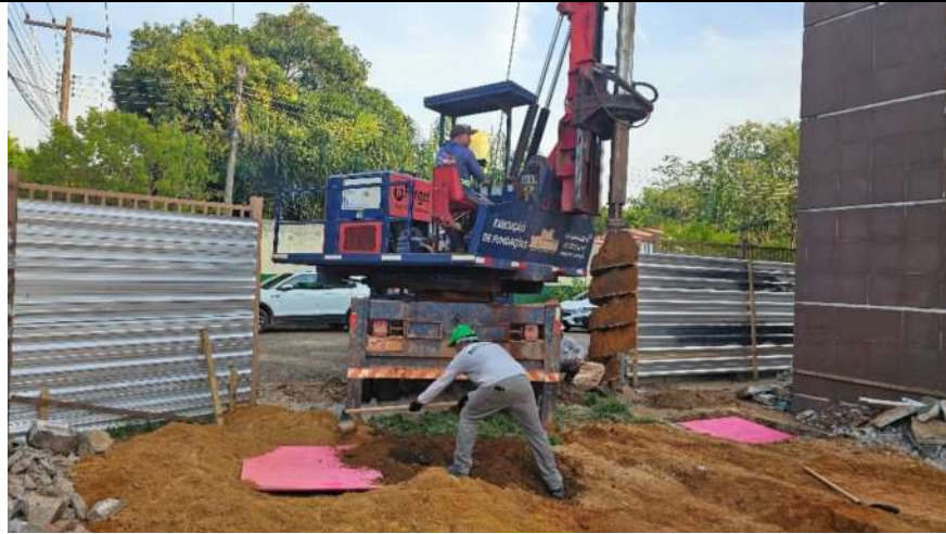
Conferência das cotas dos furos, conforme projeto estrutural:
