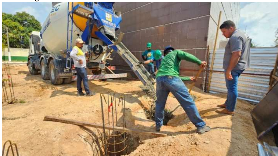
Concretagem das estacas da obra do Anexo 01:
