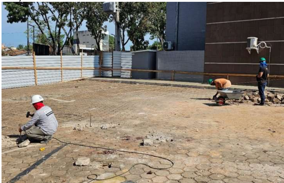
Retirada de pavimento em bloquete sextavado da região onde foi locada as estacas do Anexo 02; Demolição com martelete e escavação de camada subjacente de “pedra cabeça de jacaré” envolvida com concreto para viabilizar
