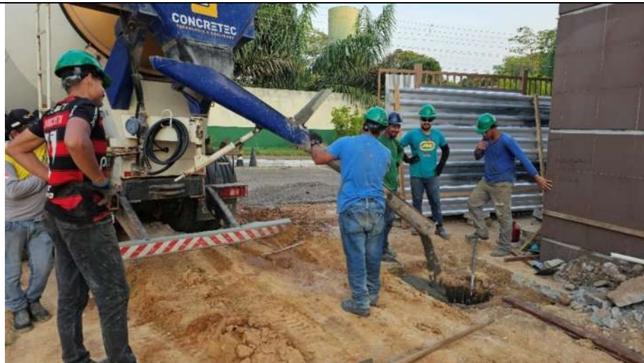
Visão geral do estacas da obra do Anexo 01 concretadas:
