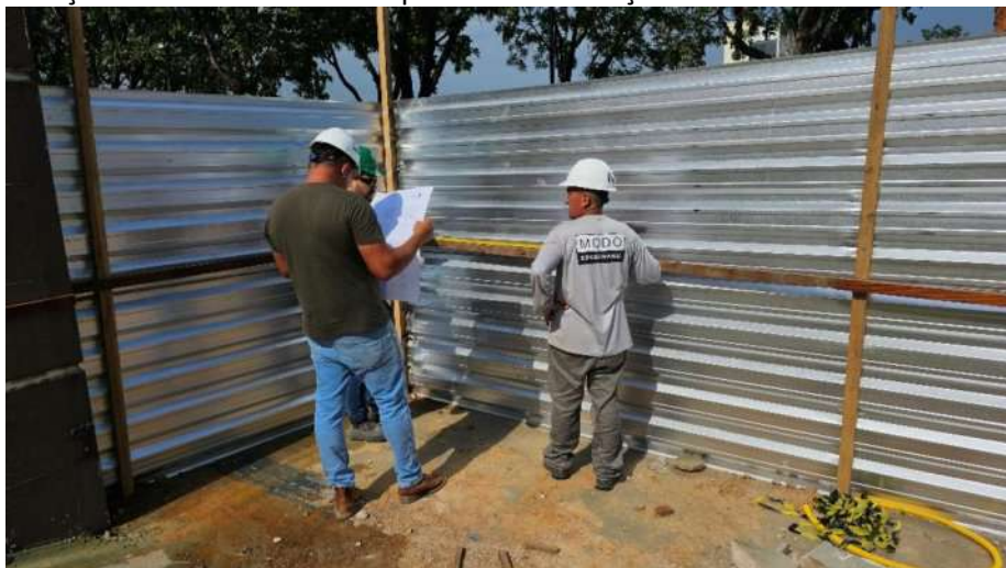
Instalação de entrada provisória de eletricidade no Anexo 01:
