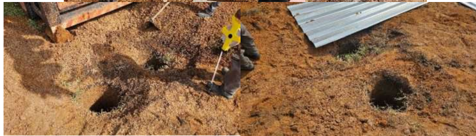
Visão geral do terreno da obra do Anexo 01, após escavação mecânica dos furos das estacas (colocou-se chapas de madeirite sobre os furos para evitar acidentes):
