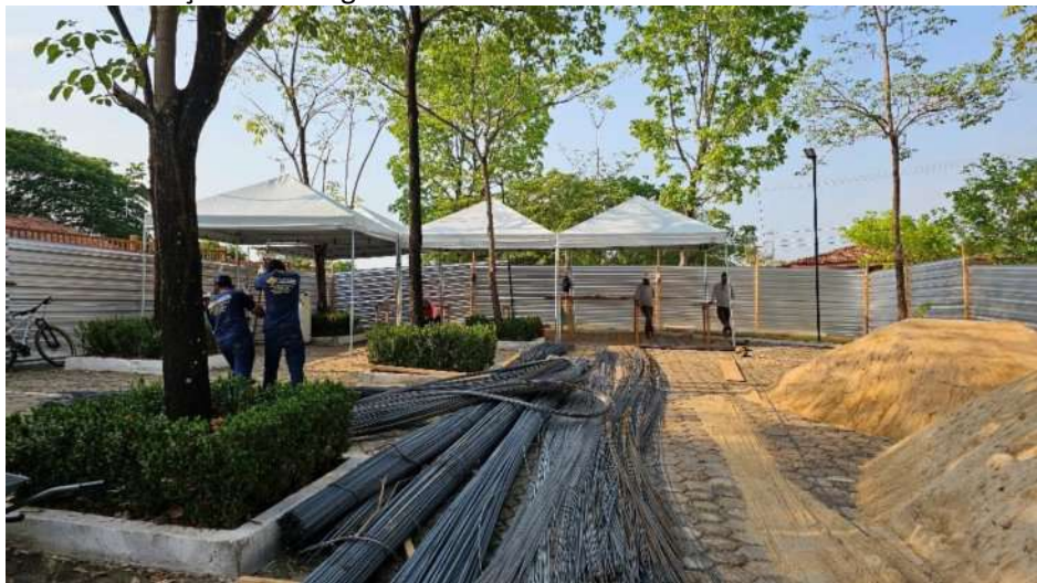
Início do fechamento com tapume de telha metálica da obra do Anexo 01:
