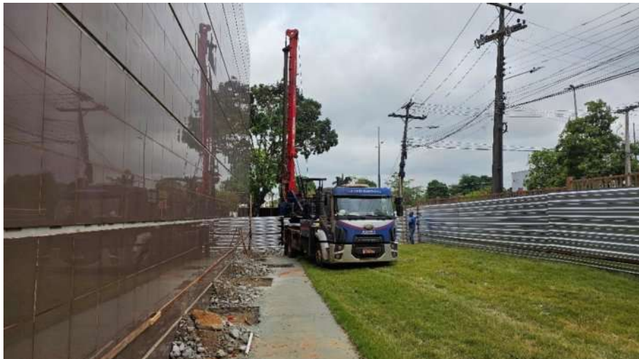
Escavação mecânica com trado rotativo das estacas da obra do Anexo 01, diâmetro dos furos 50cm:
