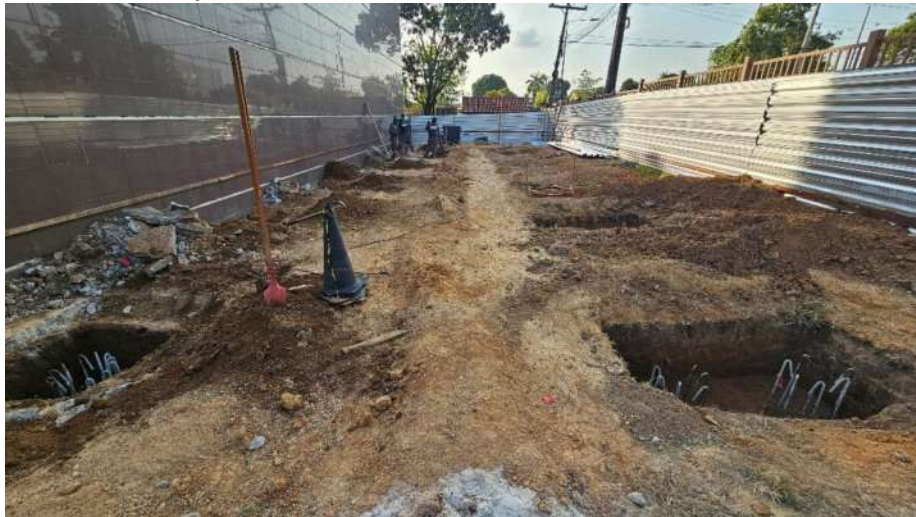
Início da escavação dos blocos de coroamento da obra do Anexo 01:
