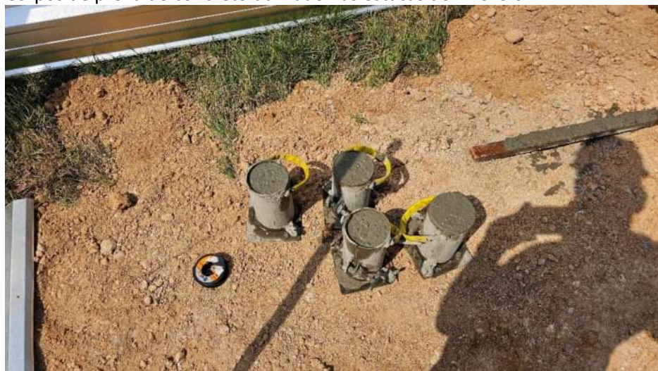
Início da escavação mecânica com trado rotativo das estacas da obra do Anexo 02, diâmetro da estaca de 70cm:
