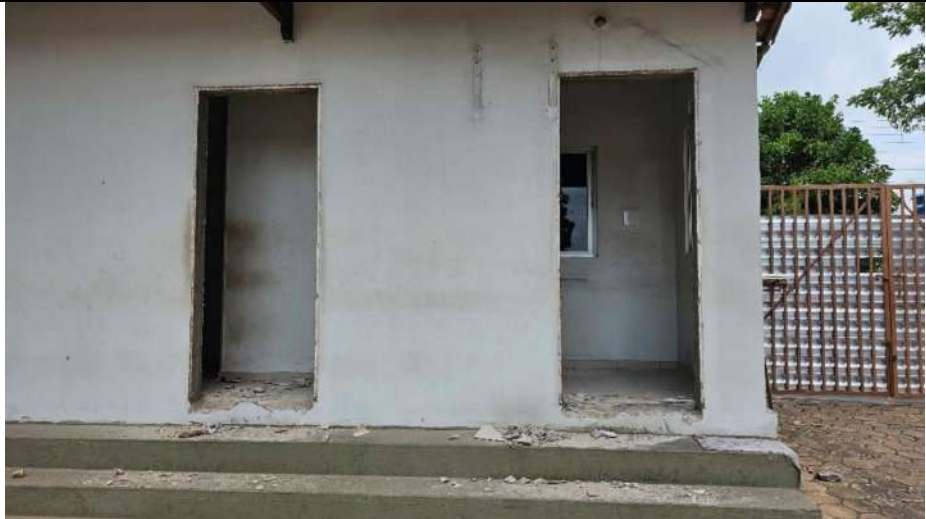
Início da montagem do gabarito da obra do Anexo 02:
