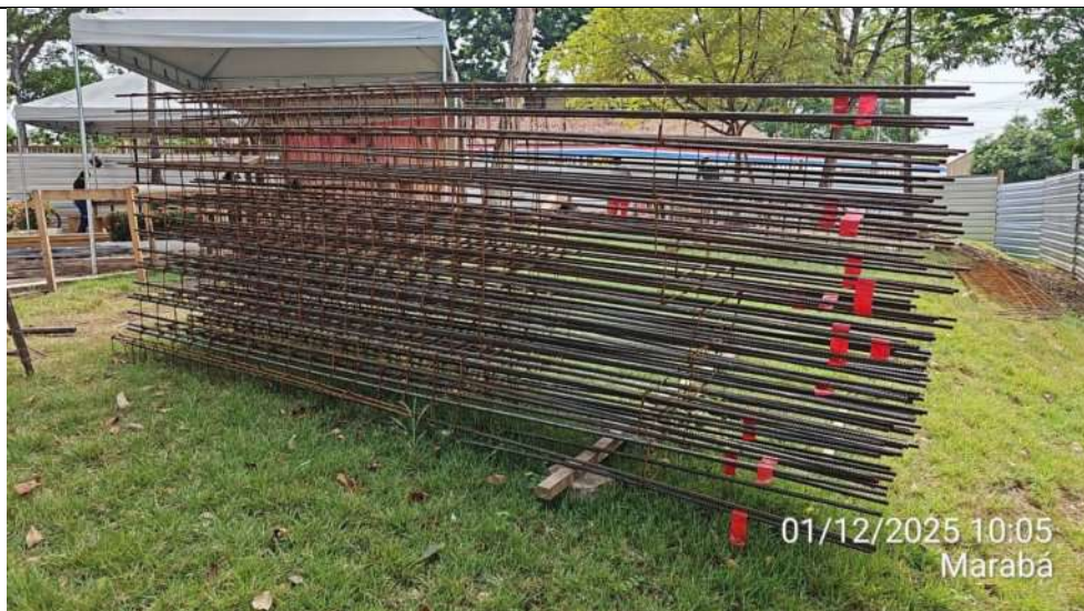
Armadura de vigas do Anexo 02, já montadas:
