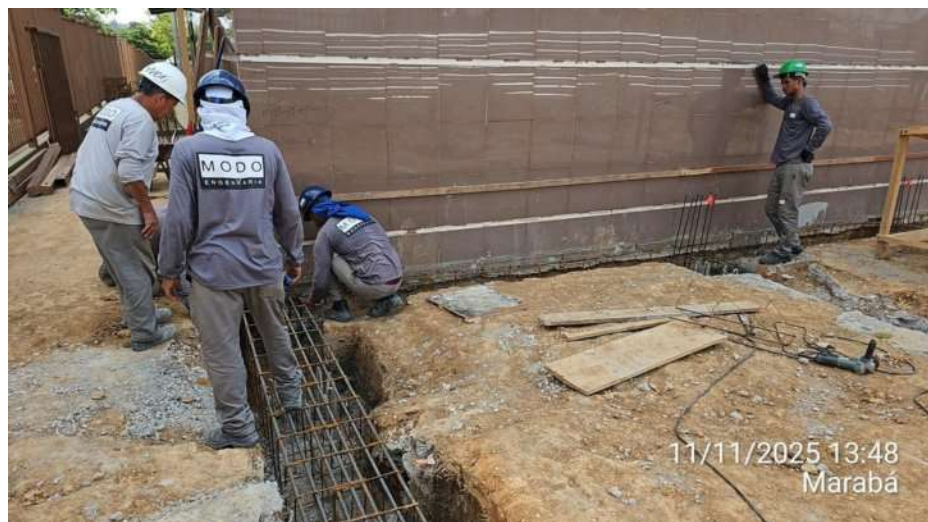
Continuação da retirada de entulho/bota-fora do Anexo 01:
