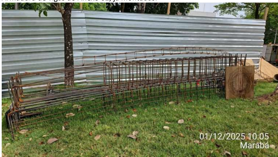
Armadura de vigas do Anexo 02, já montadas:
