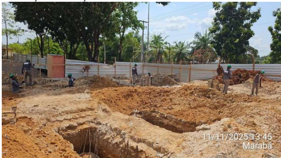
Continuação da escavação dos blocos de coroamento da obra do Anexo 02:
