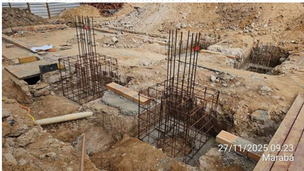
Posicionamento da armadura dos blocos de coroamento do Anexo 02:
