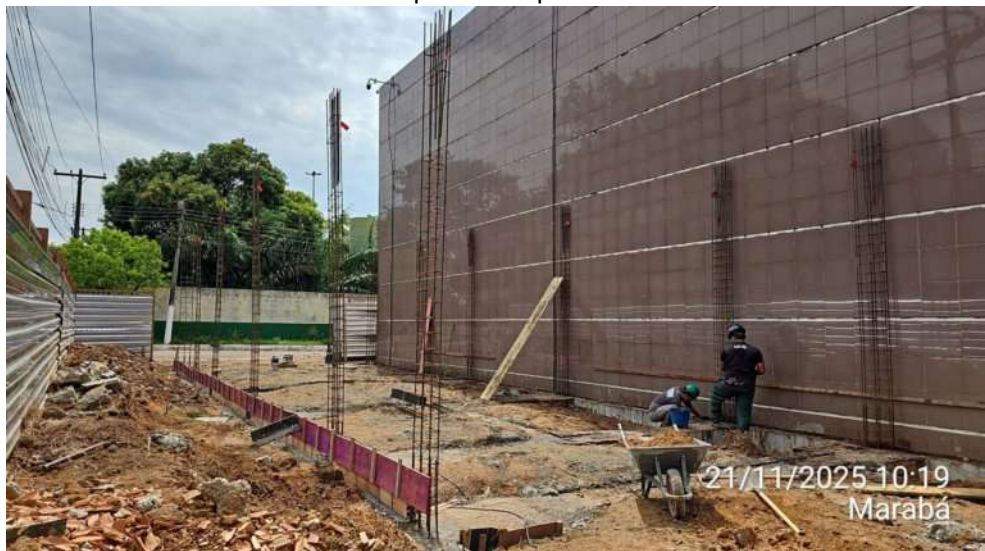
Posicionamento da armadura dos pilares do pavimento térreo do Anexo 01:
