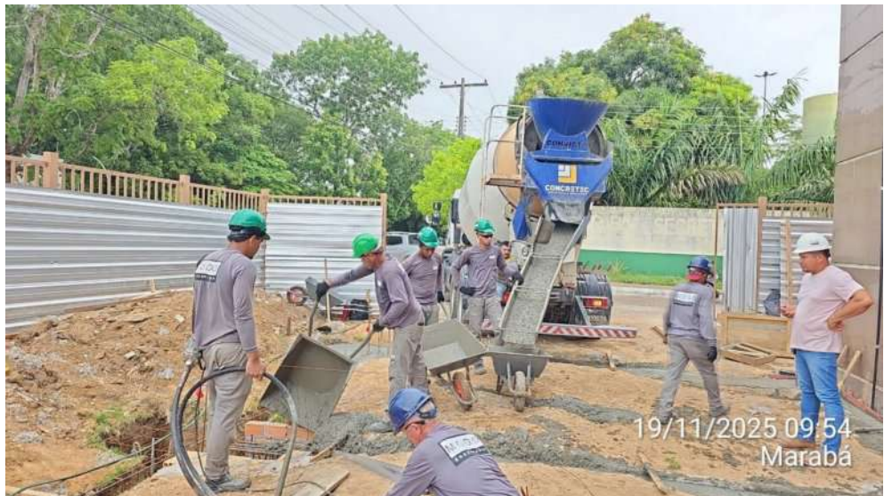
Lançamento e adensamento de concreto nas vigas baldrame da obra do Anexo 01:
