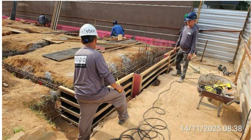
Montagem das fôrmas das vigas baldrame e blocos de coroamento do Anexo 01:
