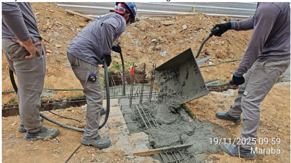
Lançamento e adensamento de concreto nas vigas baldrame da obra do Anexo 01:
