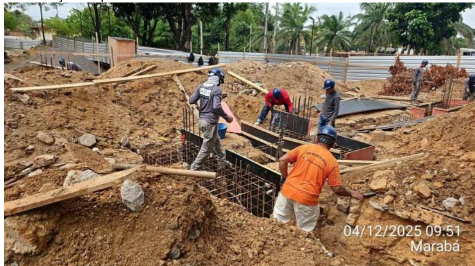
Continuação do posicionamento das fôrmas dos blocos e baldrame do Anexo 02:
