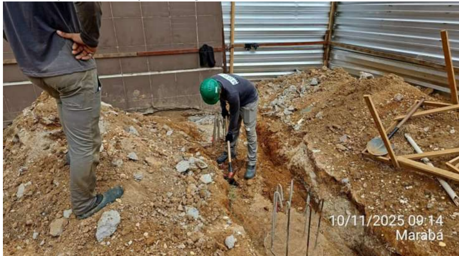
Continuação da escavação das vigas baldrame do Anexo 01:
