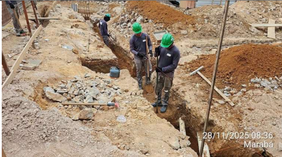
Continuação do posicionamento da armadura dos blocos e vigas baldrame do Anexo 02:
