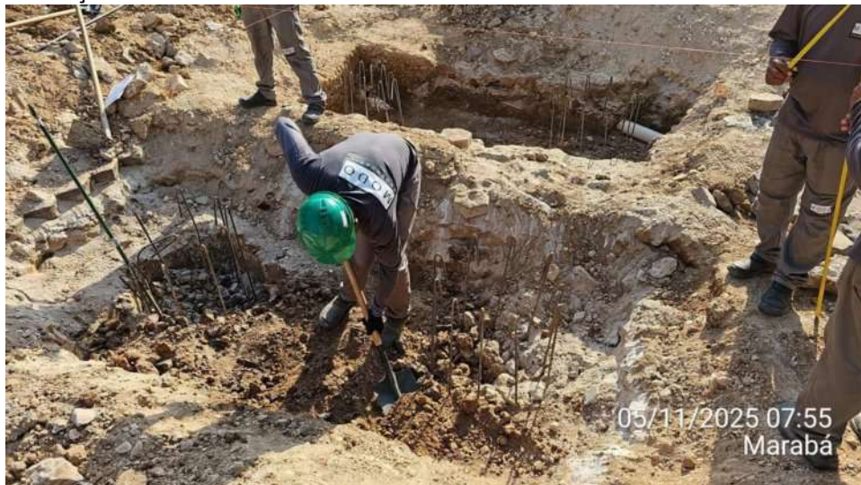
Escavação dos blocos de coroamento do Anexo 02:
