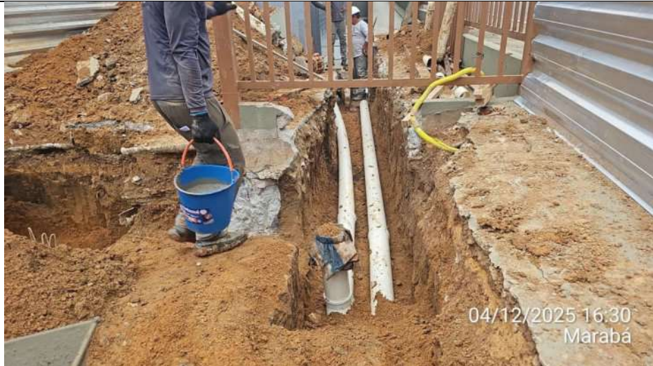
Reaterro das valas de esgoto e água pluvial:
