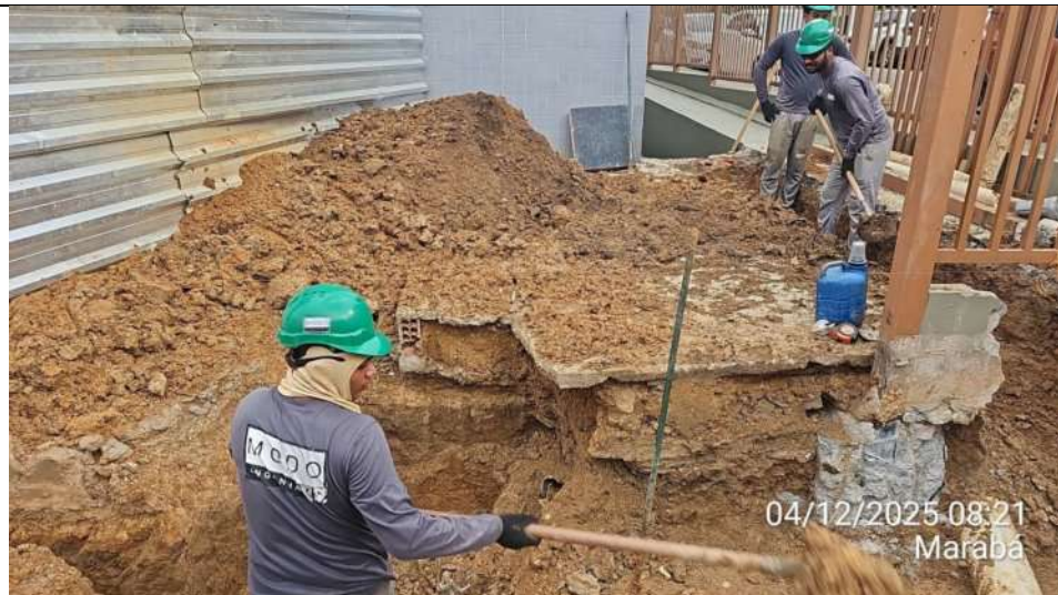
Retirada de entulho (bota-fora) do Anexo 02:
