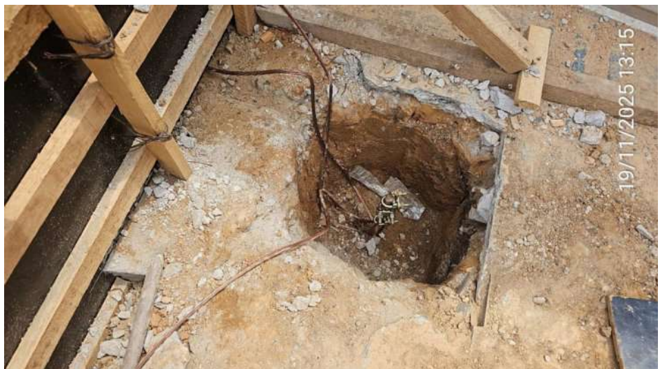
Haste de aterramento interligando malha do sistema de proteção contra descargas atmosféricas da obra do Anexo 01:
