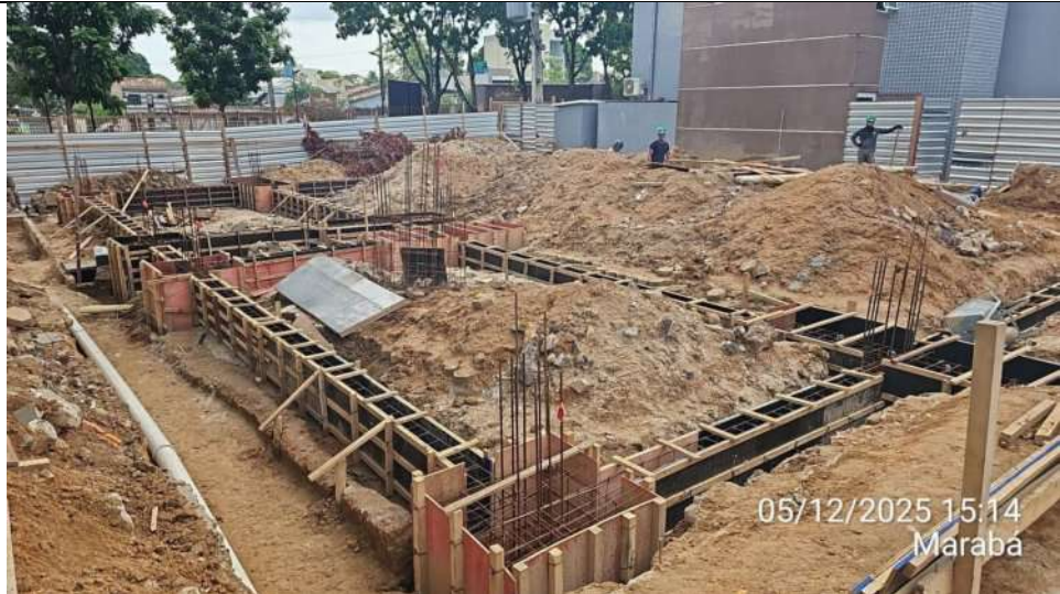
Visão geral do Anexo 01, com parte da alvenaria executada, armadura dos pilares do térreo posicionadas e com fôrmas instaladas:
