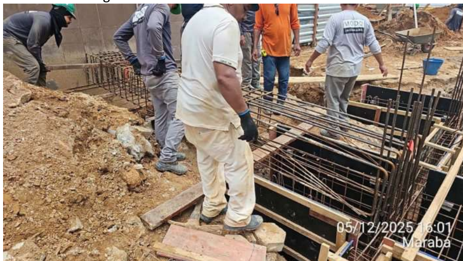
Armaduras de viga baldrame do Anexo 02:
