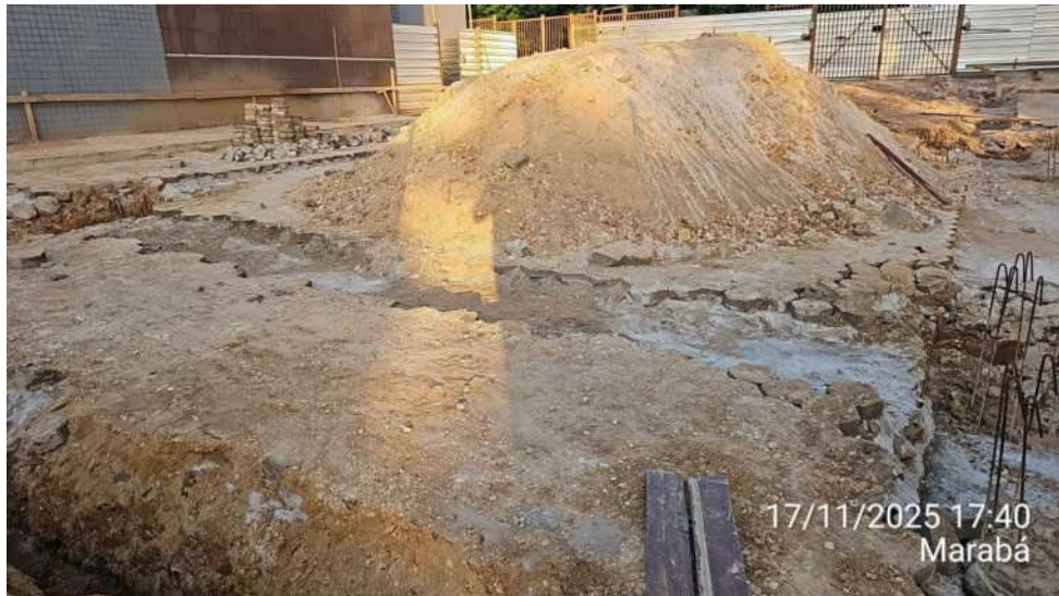
Retirada de bloquete sextavado do estacionamento e escavação das vigas baldrame da obra do Anexo 02:
