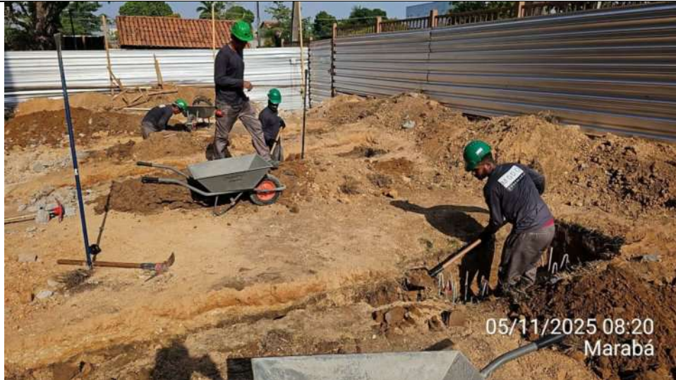
Escavação dos blocos de coroamento do Anexo 02:
