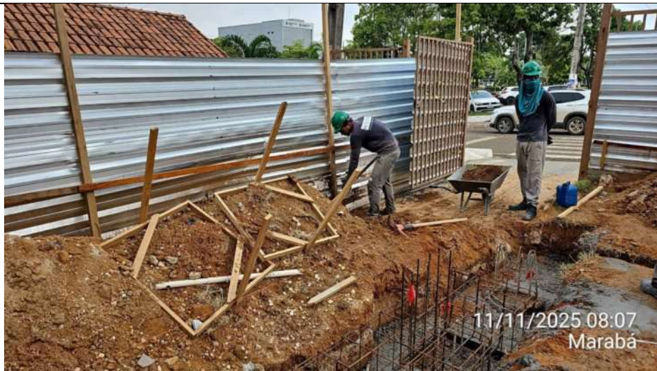
Continuação da escavação dos blocos de coroamento da obra do Anexo 02:
