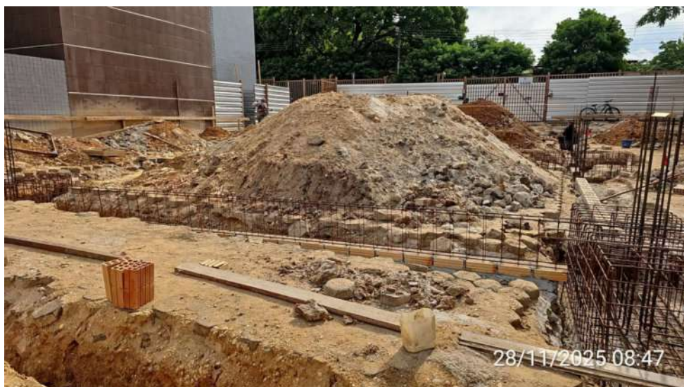
Continuação da alvenaria do Anexo 01:
