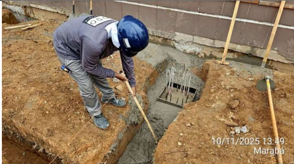
Continuação da escavação das vigas baldrame do Anexo 01:
