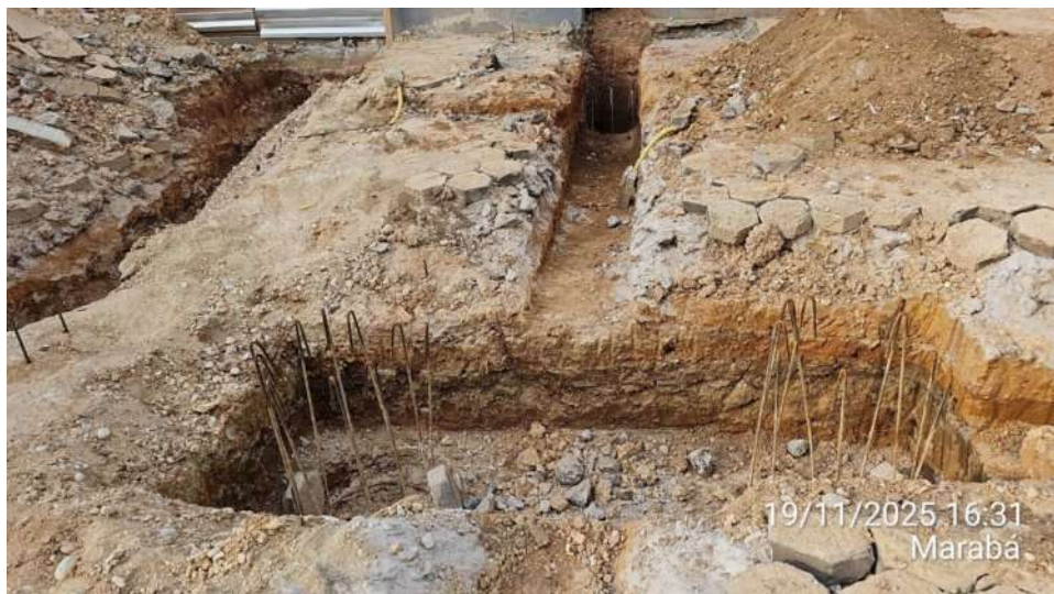
Haste de aterramento interligando malha do sistema de proteção contra descargas atmosféricas da obra do Anexo 01:
