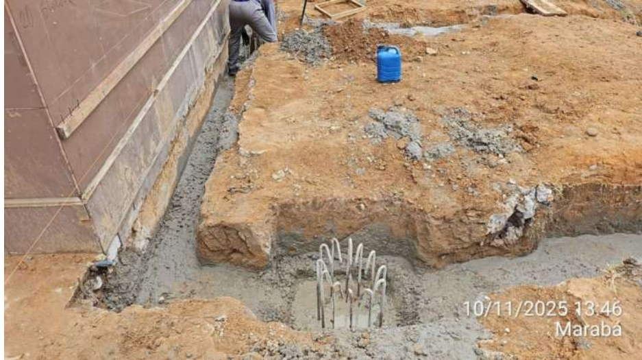
Ampliação do concreto magro das vigas baldrame e blocos do Anexo 01:
