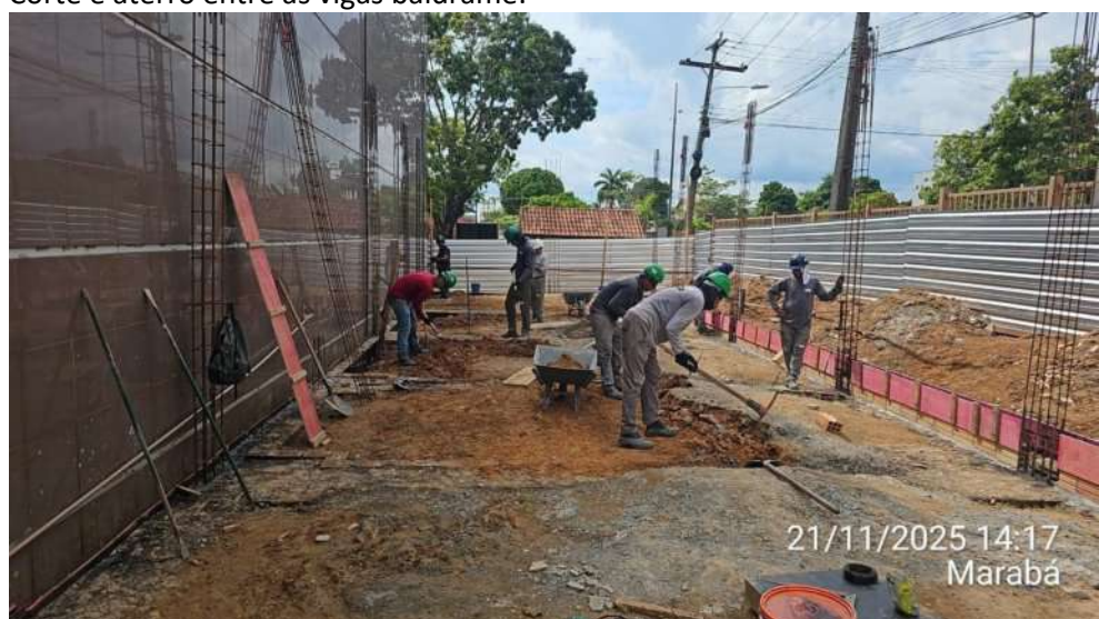
Corte e aterro entre as vigas baldrame:
