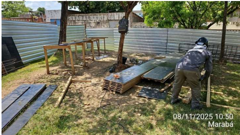
Montagem e fôrmas para vigas baldrame das obras:
