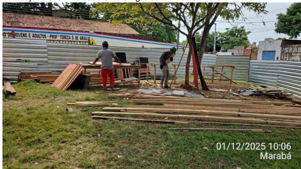
Confecção de fôrmas dos blocos e vigas baldrame do Anexo 02:
