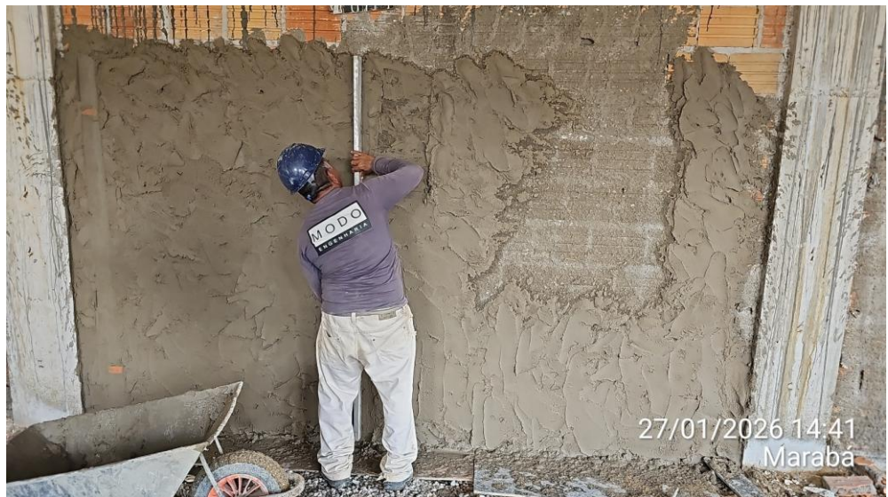
Anexo 01 – Início do reboco do Anexo 01:
