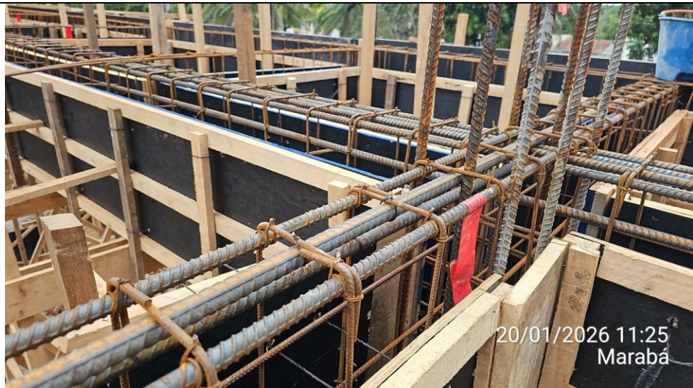
Anexo 01 – Concretagem de contra-verga e pilares do 2º pavimento do anexo 01:
