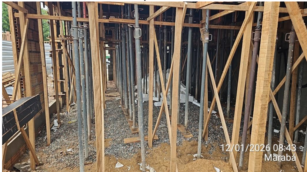
Anexo 01 – Escoramento metálico da laje:
