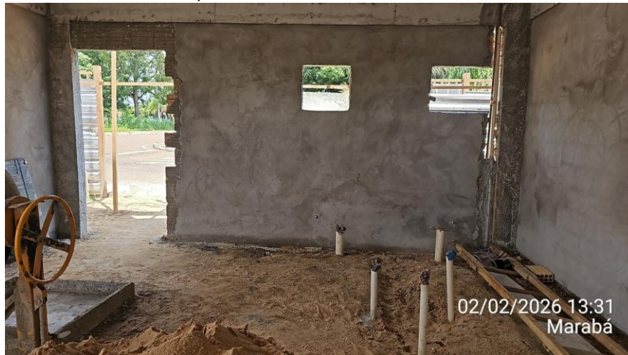
Anexo 01 – Reboco da parede do fundo onde serão os banheiros do térreo:
