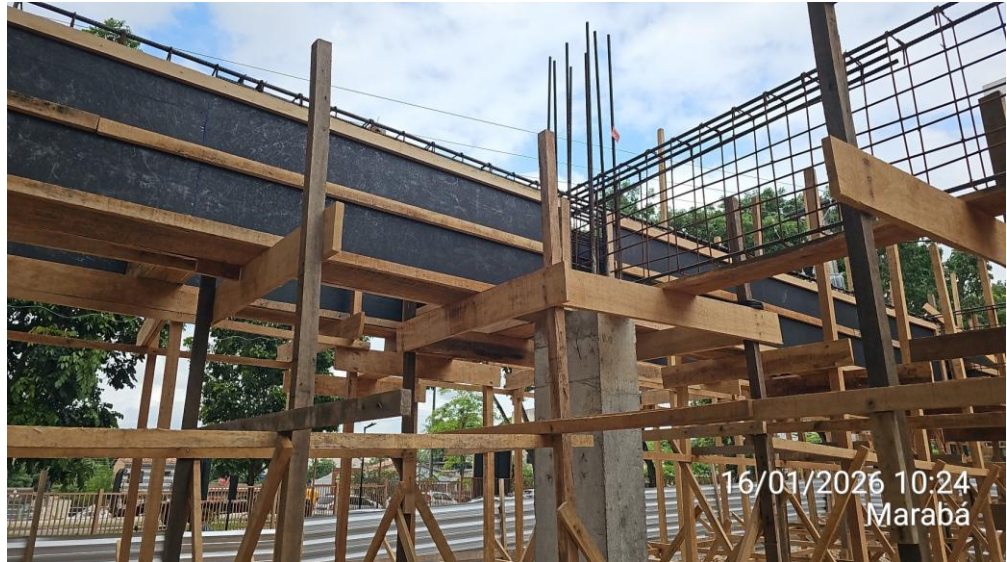
Anexo 02 – Início do fechamento das laterais das fôrmas das vigas:
