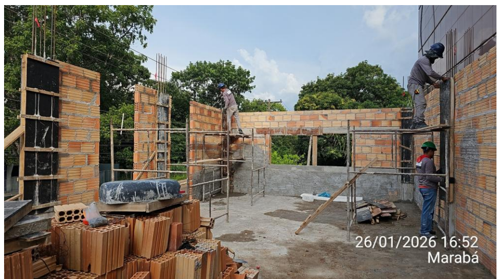
Anexo 01 – Retirada de escoramento de laje:
