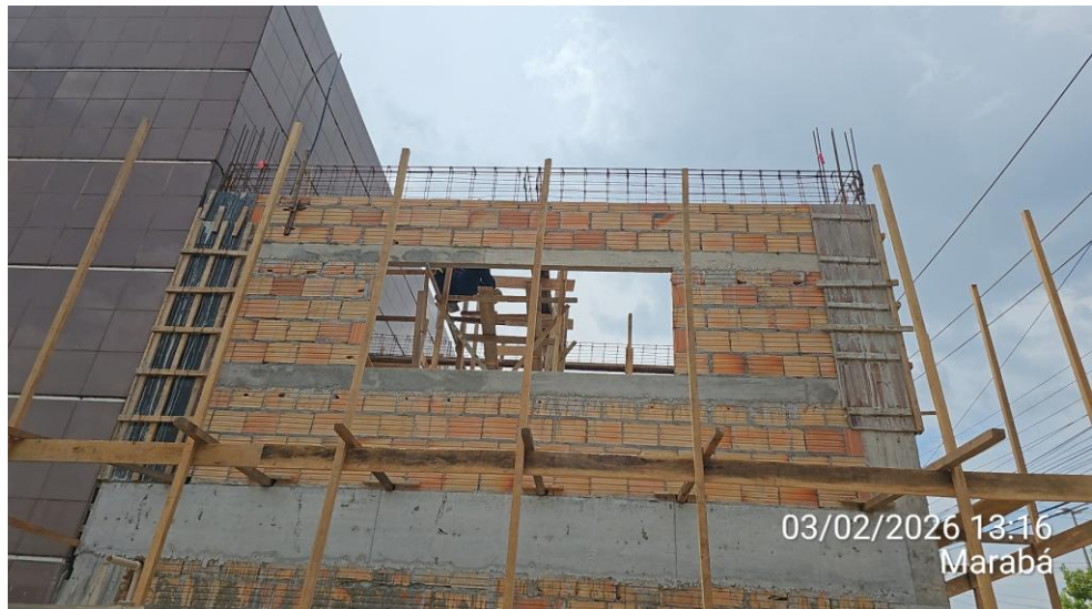
Anexo 01 – Continuação da montagem da armadura das vigas da laje de cobertura do Anexo 01:
