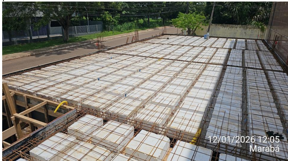
Anexo 01 – Laje montada com treliças, EPS, tela, nervuras e armaduras negativas e positivas:
