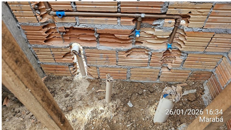
Anexo 02 – Instalação de água fria e esgoto da guarita do estacionamento:
