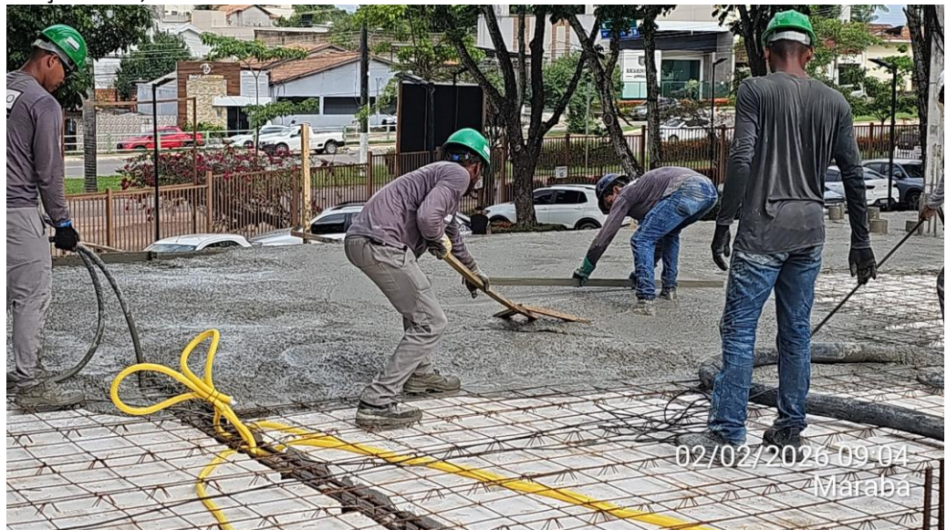
Lançamento, adensamento e acabamento de concreto usinado:
