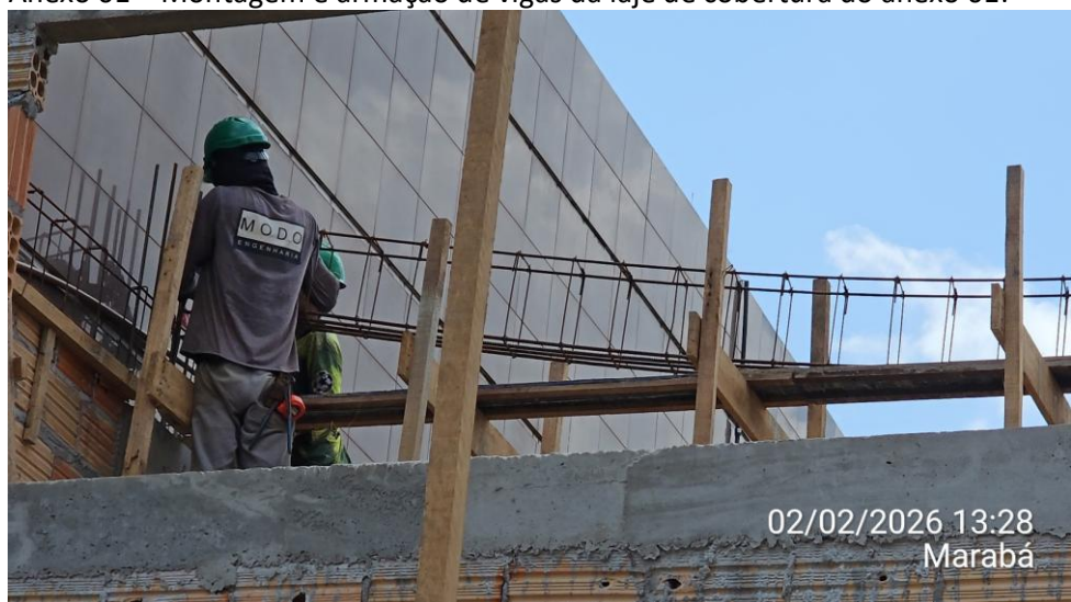
Anexo 01 – Montagem e armação de vigas da laje de cobertura do anexo 01:
