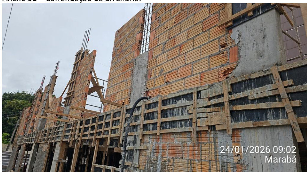
Anexo 01 – Continuação da alvenaria:
