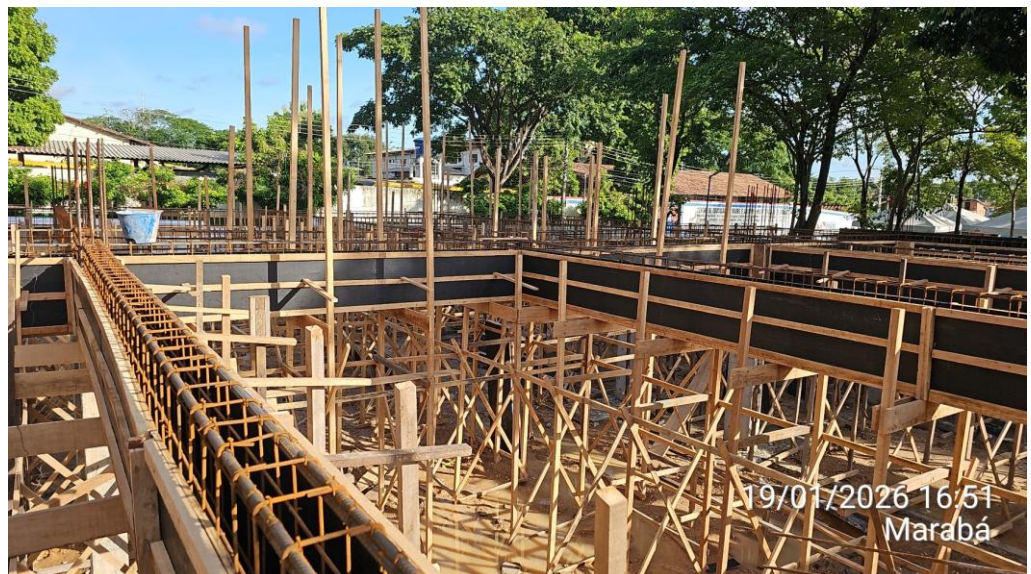
Anexo 01 – Continuação da alvenaria do 2º pavimento: e colocação das fôrmas dos pilares e cura da laje:
