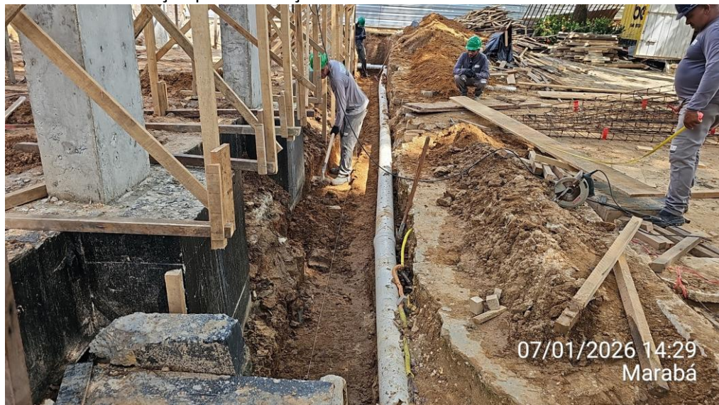
Anexo 02 – Escavação para inclinação do assentamento de manilhas:
