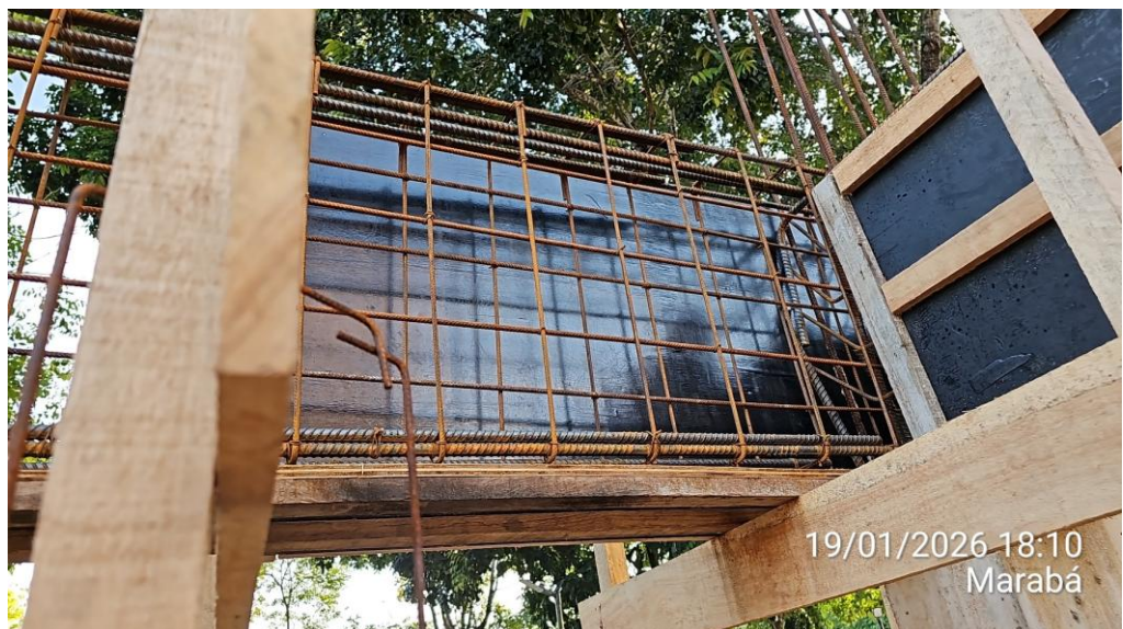
Anexo 02 – Continuação do fechamento das laterais das fôrmas das vigas:
