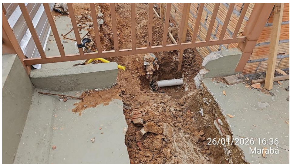
Anexo 01 – Vista lateral da obra anexo 01:
