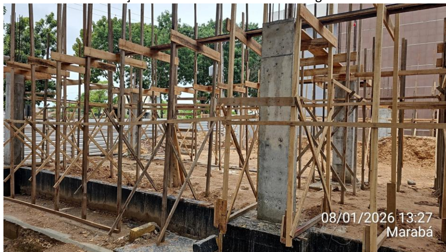
Anexo 02 – Continuação de fôrmas de madeira das vigas:
