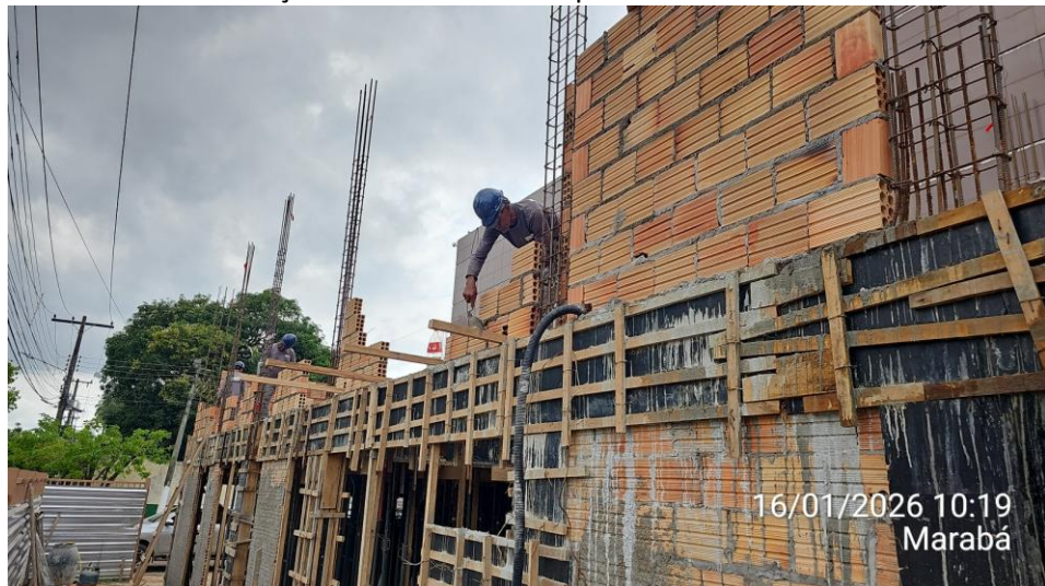
Anexo 01 – Continuação da alvenaria do 2º pavimento:
