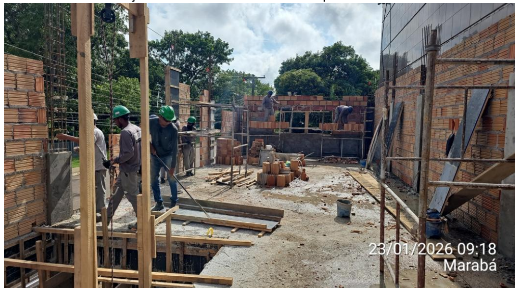
Anexo 01 – Continuação da alvenaria e desfôrma de pilares:
