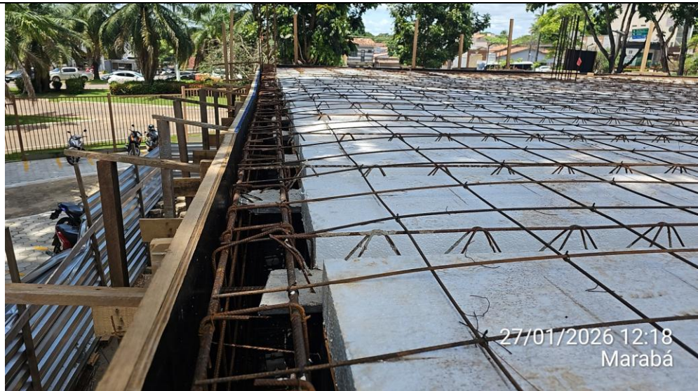
Anexo 02 – cocada no fundo da viga para cobrimento:
