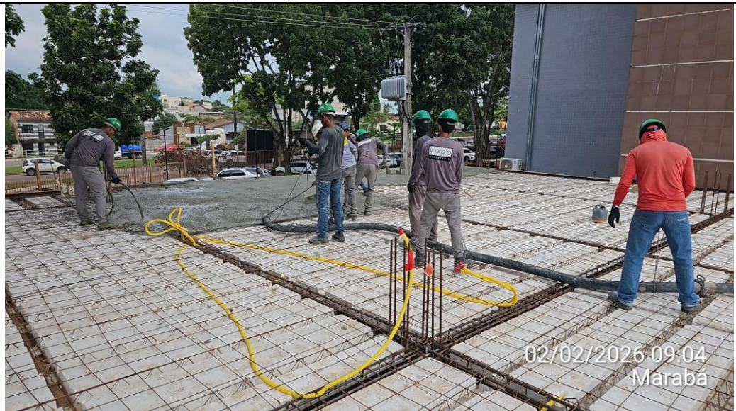
Lançamento, adensamento e acabamento de concreto usinado:
