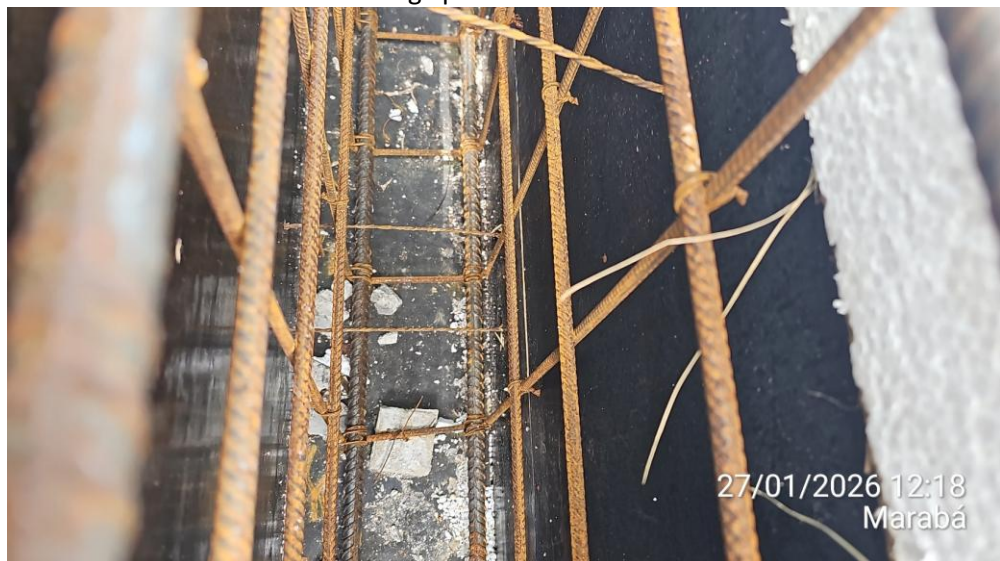
Anexo 02 – cocada no fundo da viga para cobrimento:
