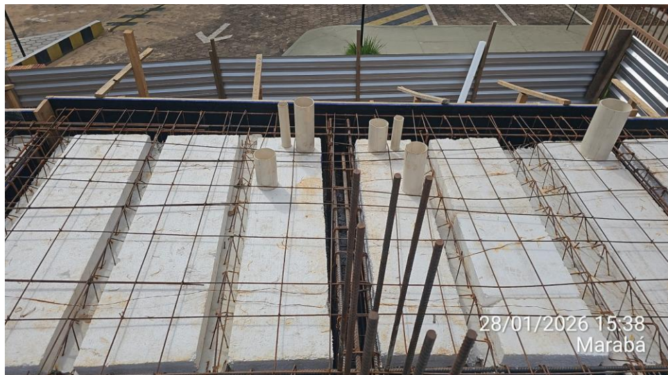
Anexo 02 – passagem de tubulações para instalação de esgoto e água pluvial pelos lavabos
