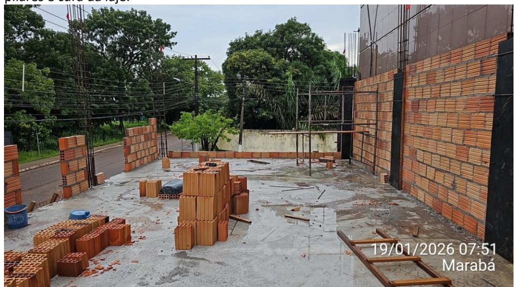
Anexo 01 – Continuação da alvenaria do 2º pavimento: e colocação das fôrmas dos pilares e cura da laje:
