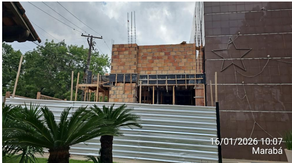
Vista frontal da obra Anexo 01:
