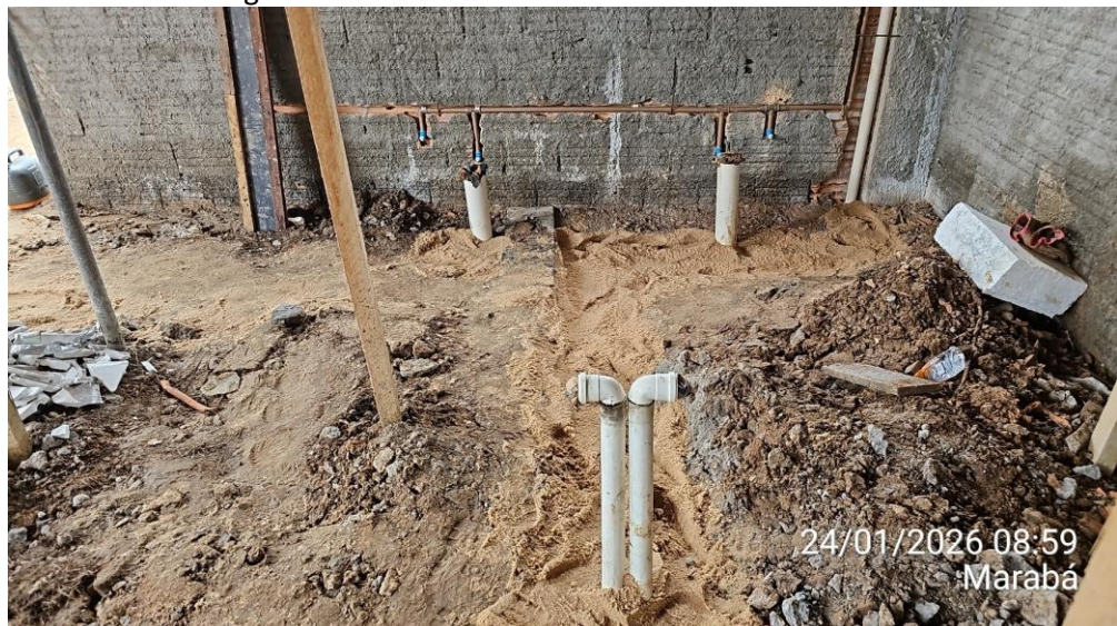
Anexo 01 – Instalação de água fria e esgoto dos banheiros do pavimento térreo do Anexo 01 com rasgos e reaterro:
