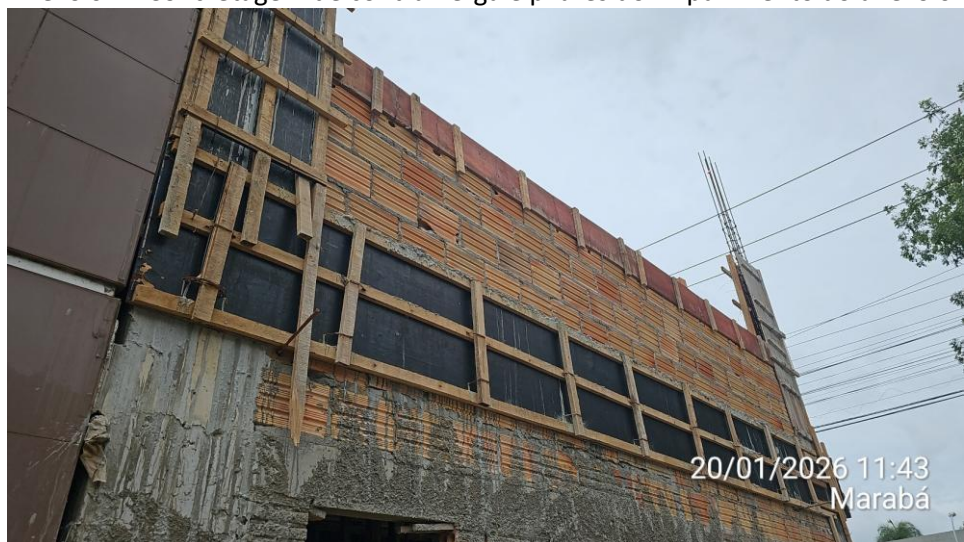
Anexo 01 – Concretagem de contra-verga e pilares do 2º pavimento do anexo 01:
