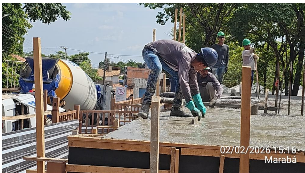
Anexo 01 – Montagem e armação de vigas da laje de cobertura do anexo 01:
