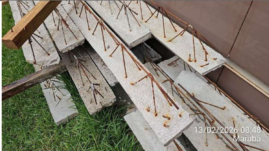
Anexo 02 – Início da armação das vigas do 2º pavimento do Anexo 02:
