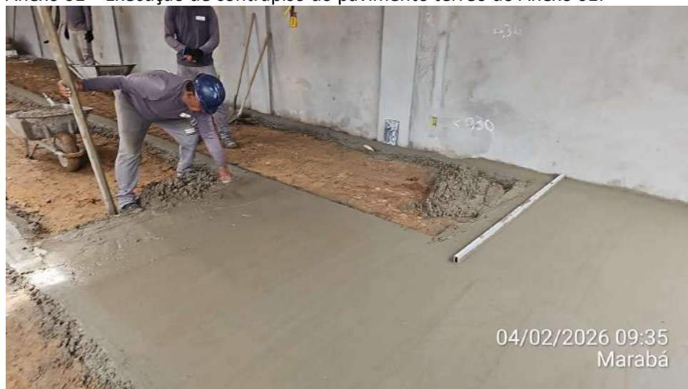
Anexo 01 – Execução de contrapiso do pavimento térreo do Anexo 01:
