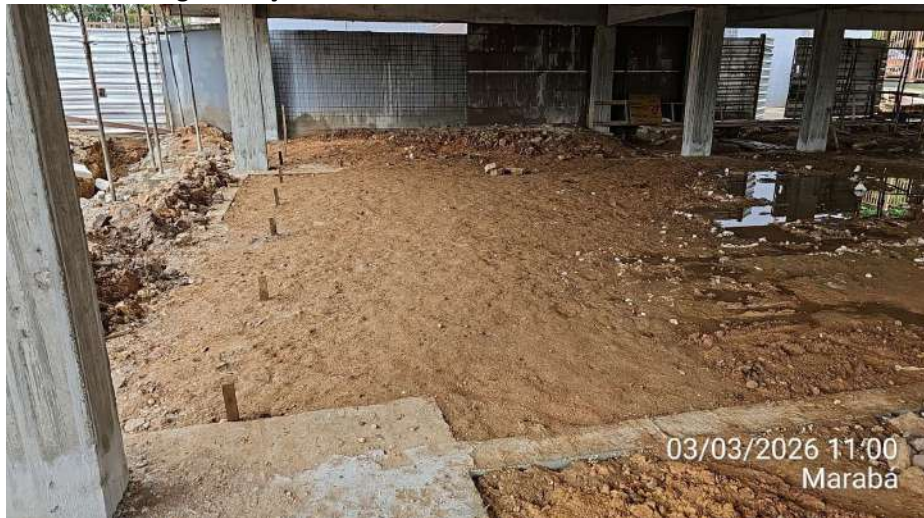
Anexo 02 – Regularização do solo do estacionamento:
