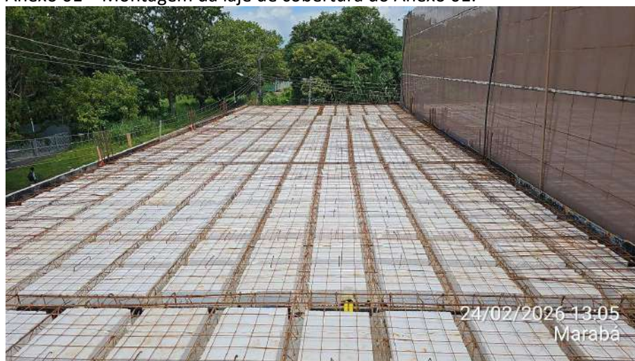
Anexo 01 – Montagem da laje de cobertura do Anexo 01:
