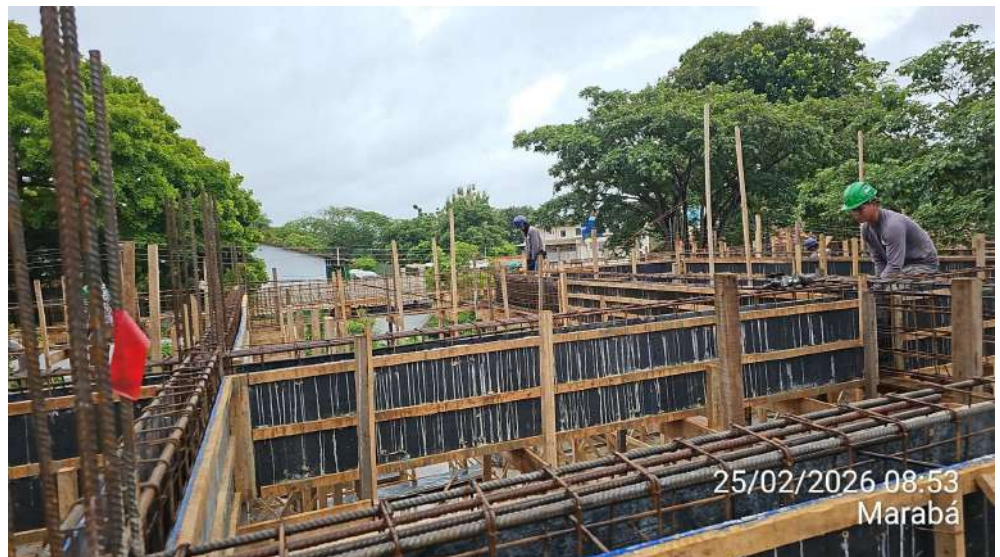
Anexo 01 – Montagem da laje de cobertura do Anexo 01 com armaduras negativas e positivas posicionadas:
