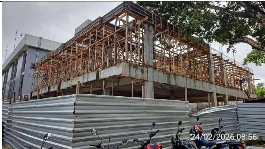
Anexo 02 – Remoção das escoras metálicas da 1ª laje do Anexo 02:
