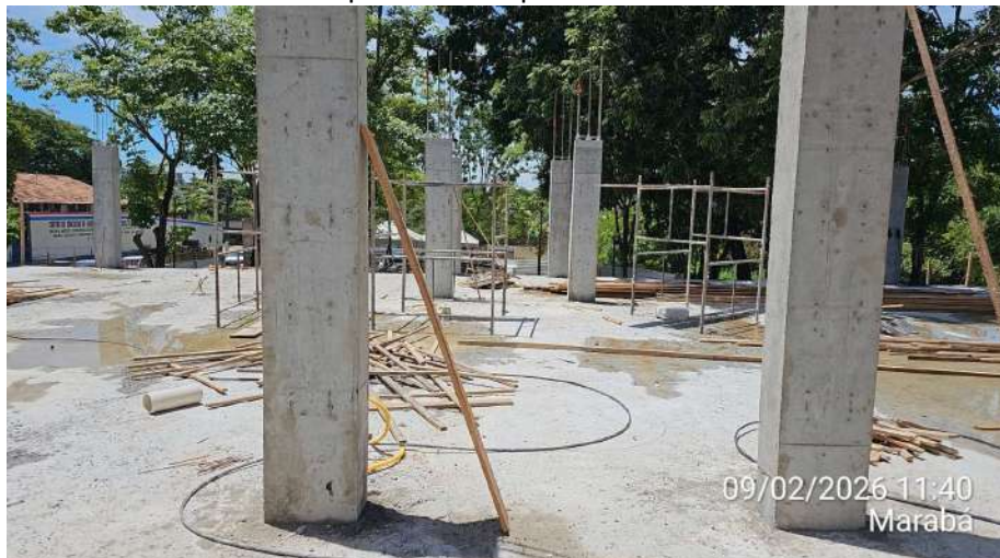
Anexo 02 – Desfôrma dos pilares do 2º pavimento do Anexo 02:
