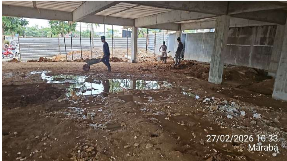
Anexo 02 – Regularização do solo do estacionamento:
