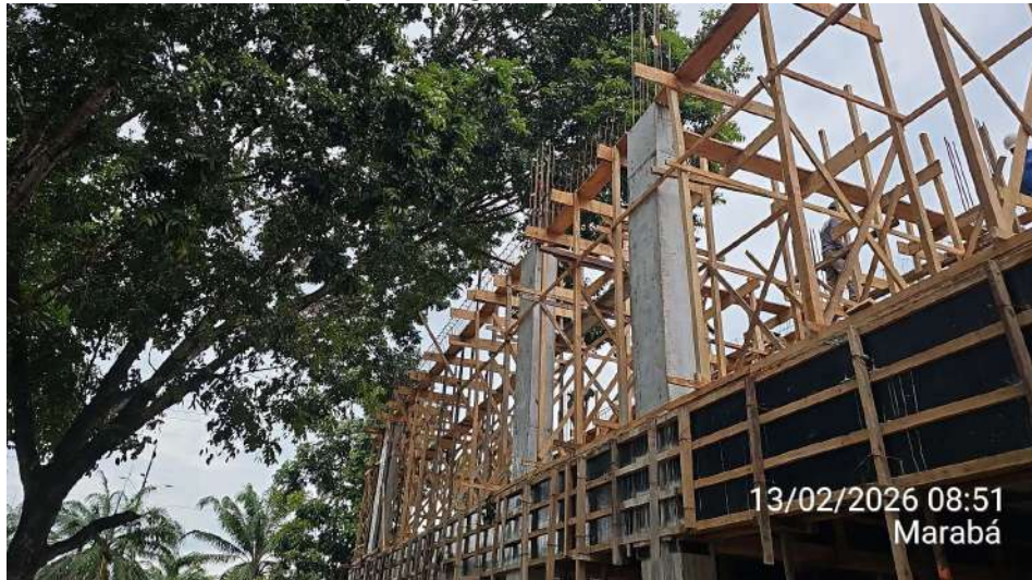
Anexo 02 – Início da armação das vigas do 2º pavimento do Anexo 02:
