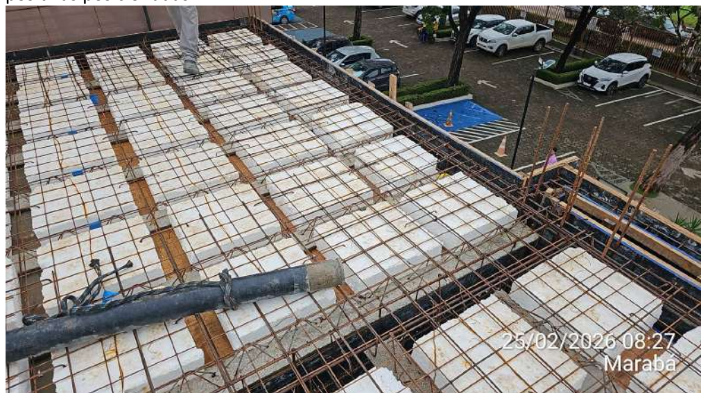
Anexo 01 – Montagem da laje de cobertura do Anexo 01 com armaduras negativas e positivas posicionadas:
