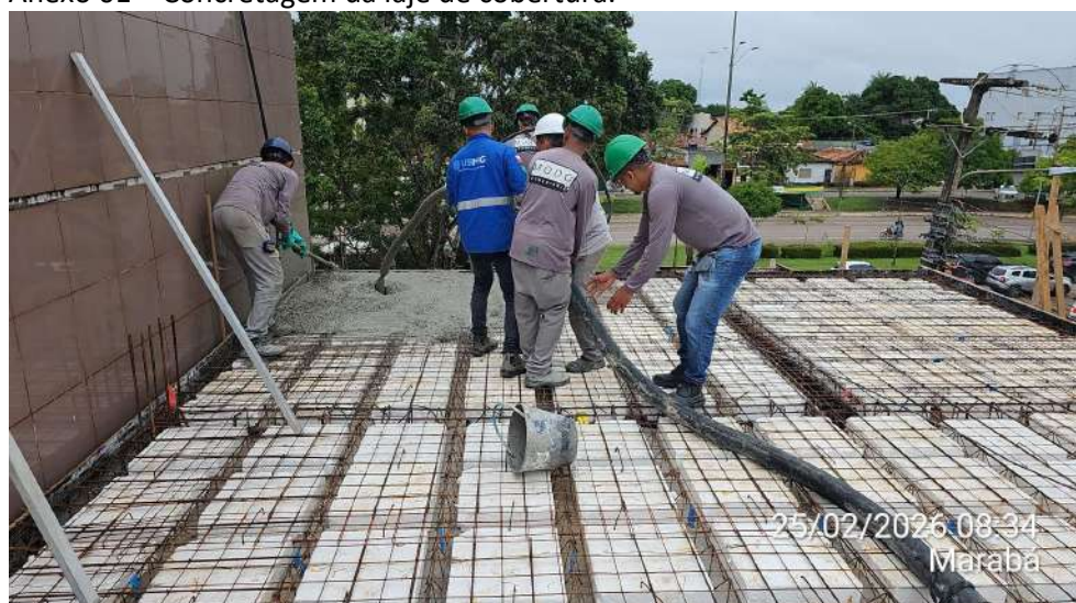
Anexo 01 – Concretagem da laje de cobertura.
