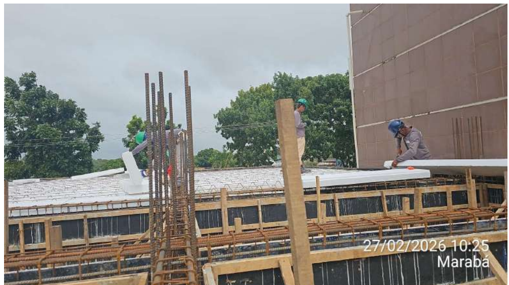
Anexo 02 – Início da colocação do escoramento metálico da laje do 2º pavimento do Anexo 02:
