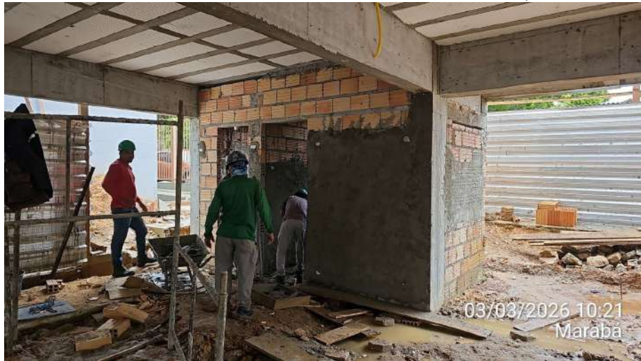
Anexo 02 – Início do reboco do lavabo do estacionamento e depósito:
