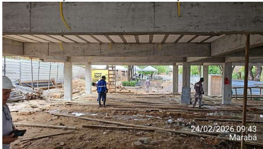
Anexo 02 – Remoção das escoras metálicas da 1ª laje do Anexo 02:
