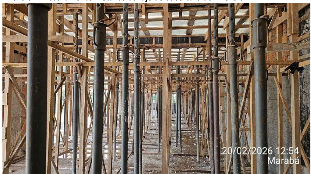
Anexo 01 – Escoramento metálico da laje de cobertura do Anexo 01:
