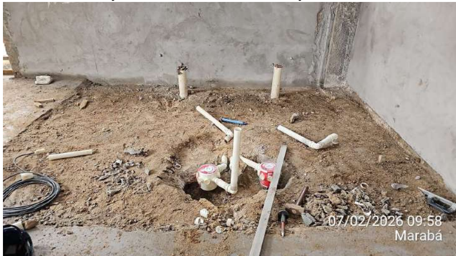
Anexo 01 – Instalação de caixas sifonadas e tubulação dos banheiros do térreo:
