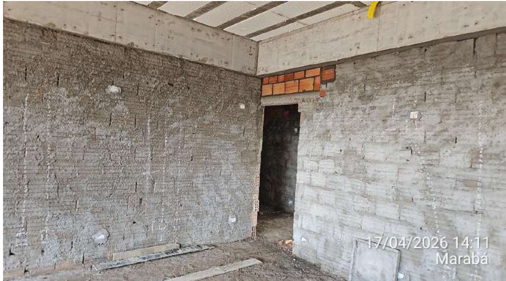
Anexo 02 – Chapisco em alvenaria e verga de porta.
