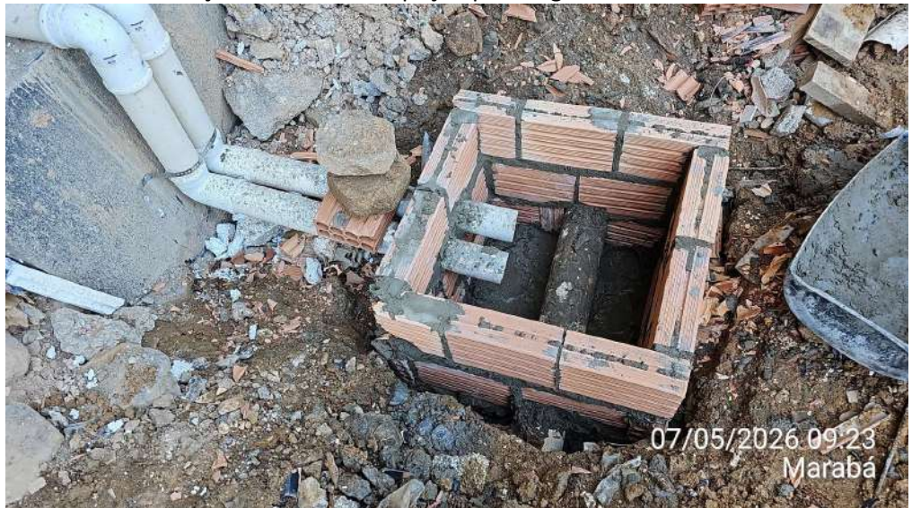
Anexo 02 - confecção de caixa de inspeção para esgoto:
