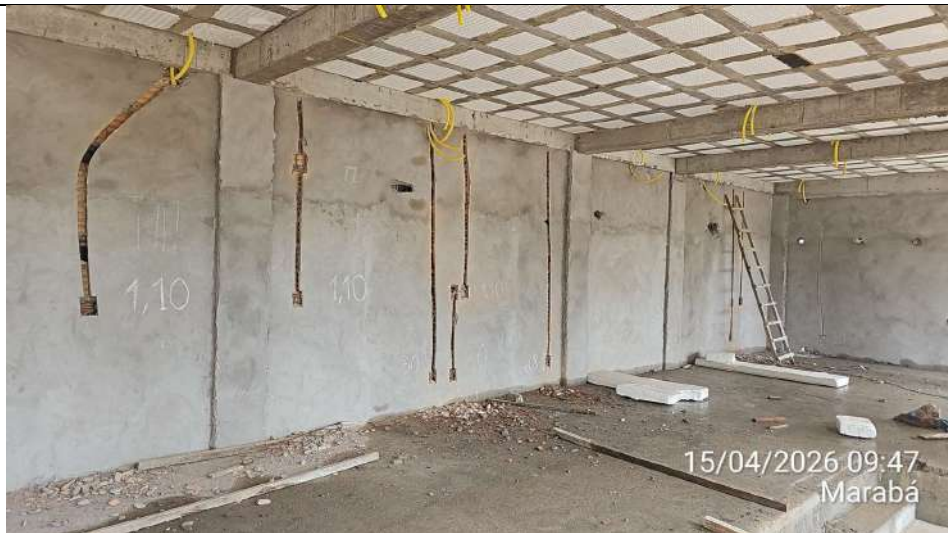
Anexo 01 – Continuação da montagem de fôrmas das vigas superiores:
