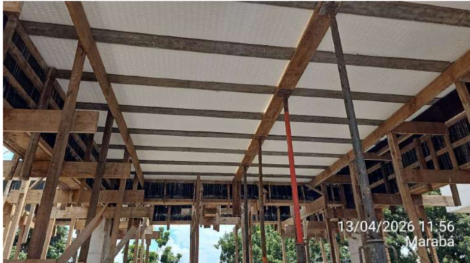
Anexo 02 – Montagem da laje de cobertura e colocação do escoramento metálico:
