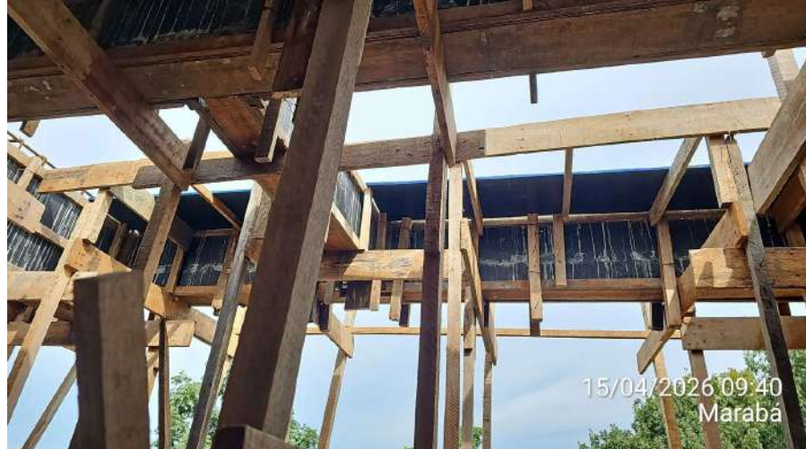
Anexo 02 – Montagem de fôrmas inferiores da calha e marquise de concreto armado:
