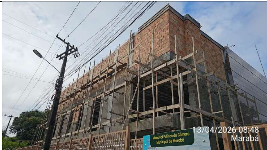
Anexo 02 - Continuação da alvenaria do 2º pavimento:
