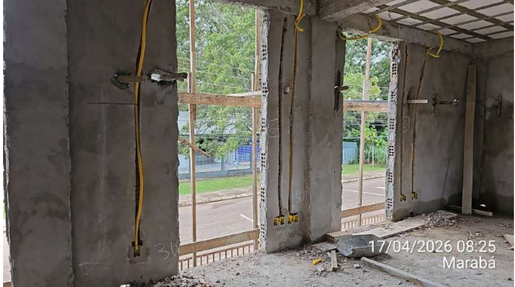
Anexo 01 – Instalação de eletrodutos em rasgos de alvenaria para elétrica e rede lógica.
