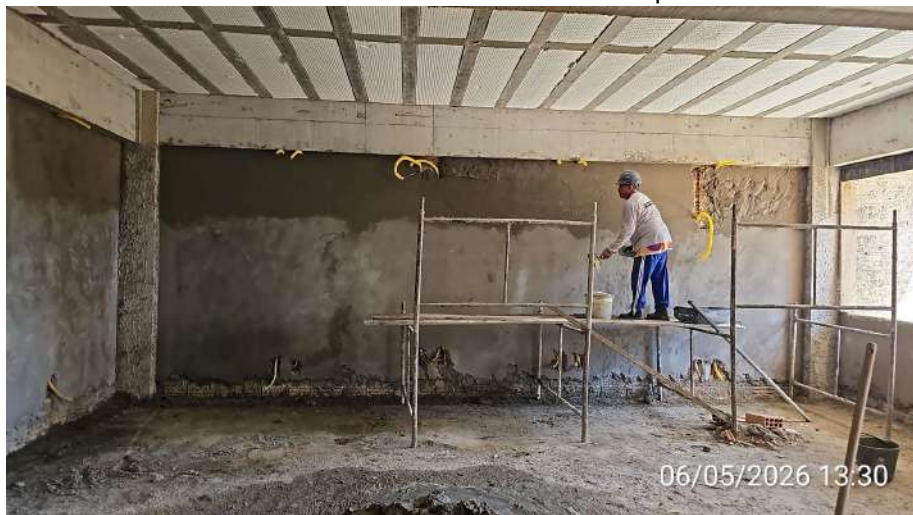
Anexo 02 – Reboco do lado interno da alvenaria do 2º pavimento:
