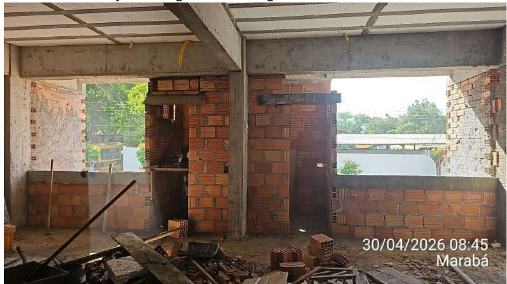
Anexo 02 – Confeção de vergas e contravergas:
