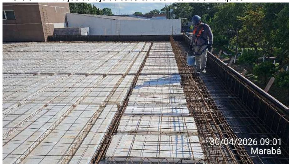
Anexo 02 – Armação da laje de cobertura com calhas e marquise:
