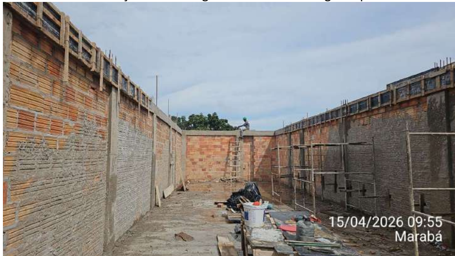
Anexo 01 – Continuação da montagem de fôrmas das vigas superiores:
