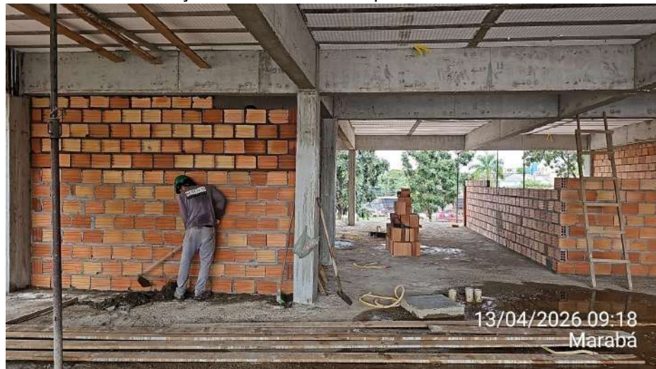
Anexo 02 - Continuação da alvenaria do 2º pavimento:
