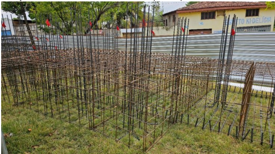
Armação dos blocos de coroamento e arranque dos pilares do Anexo 02:
