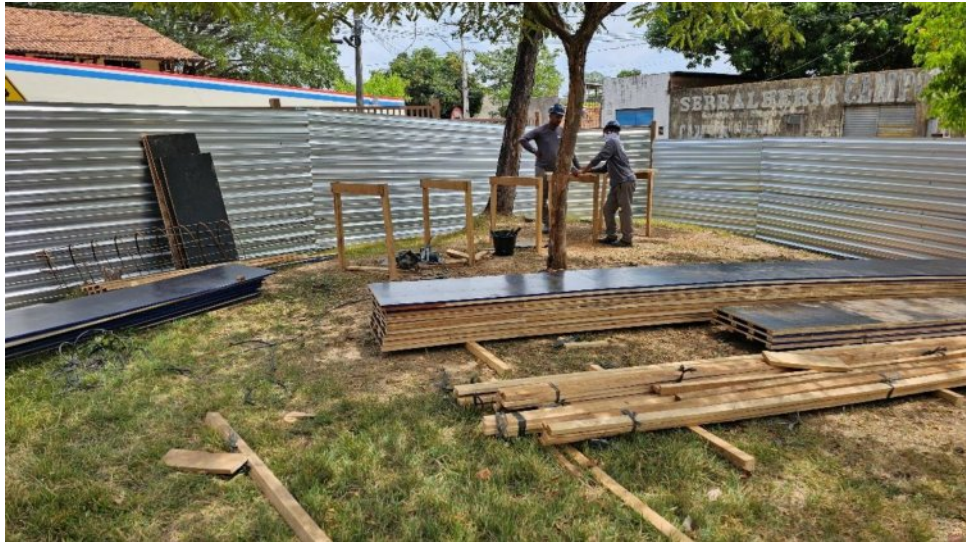
Montagem de fôrmas para vigas baldrame e blocos do Anexo 02:
