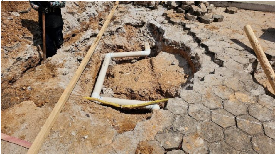
Desvio provisório da tubulação de esgoto existente do prédio para viabilizar a perfuração mecânica das estacas do Anexo 02:
