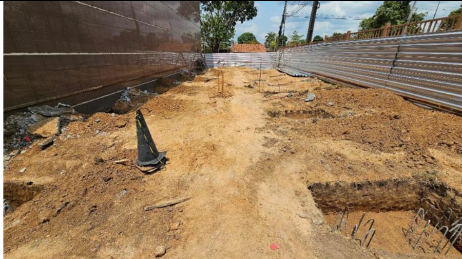
Concretagem e posicionamento das armações das estacas da obra do Anexo 02:
