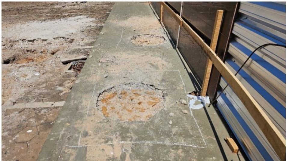
Continuação da armação de blocos e arranques de pilares da obra do anexo 02:
