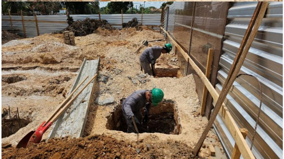
Armação das vigas baldrame da obra do Anexo 02:
