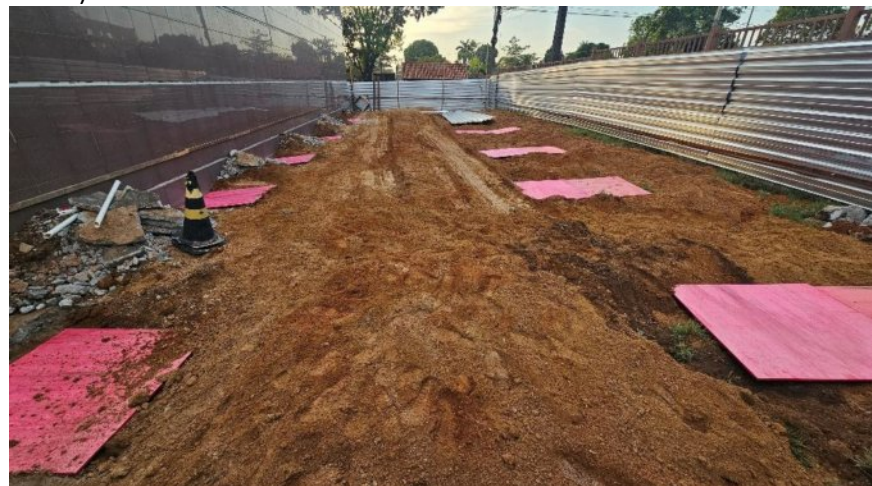
Visão geral do terreno da obra do Anexo 01, após escavação mecânica dos furos das estacas (colocou-se chapas de madeirite sobre os furos para evitar acidentes):
