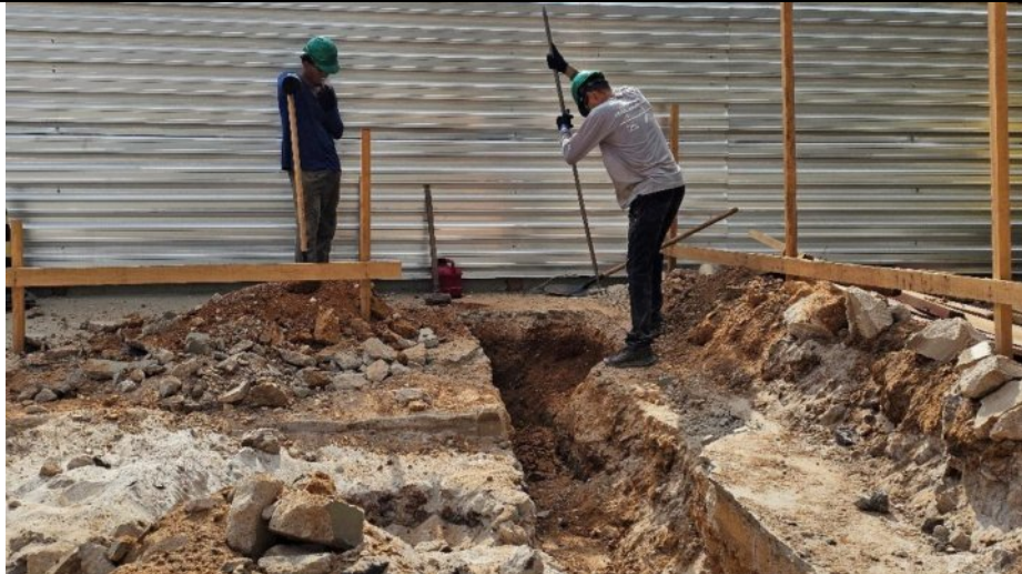
Início da armação dos blocos de coroamento e arranque dos pilares da obra do Anexo 01:
