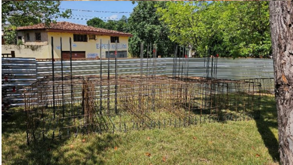
Locação do eixo das estacas e pilares das fundações do Anexo 01:
