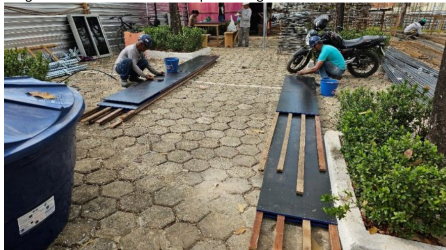
Montagem de formas de madeirite para as vigas baldrame das obras:
