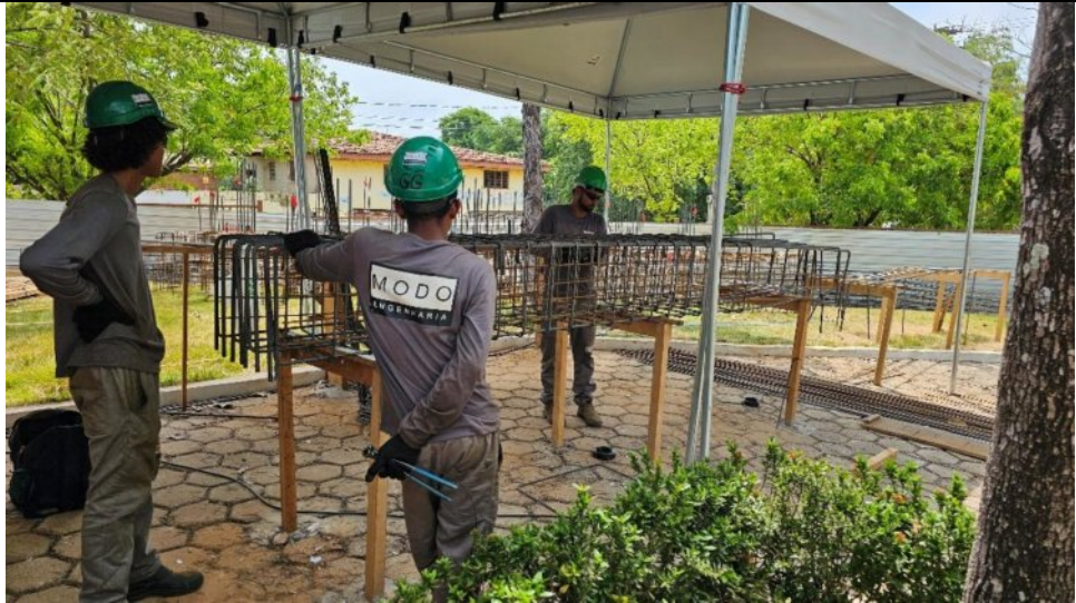
Montagem de fôrmas para vigas baldrame e blocos do Anexo 02:
