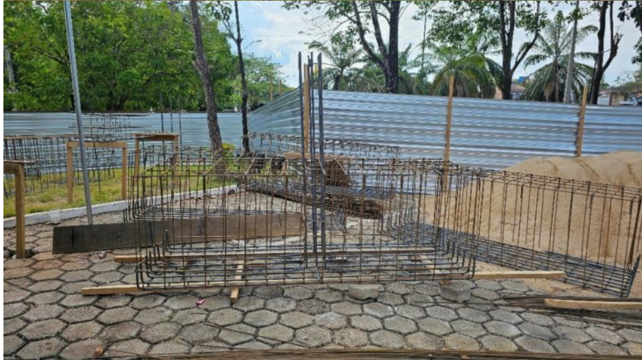
Locação das estacas da obra do Anexo 02:
