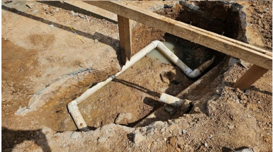
Demolição de concreto simples da calçada da obra do Anexo 01 para viabilizar a escavação das estacas por trado mecânico:
