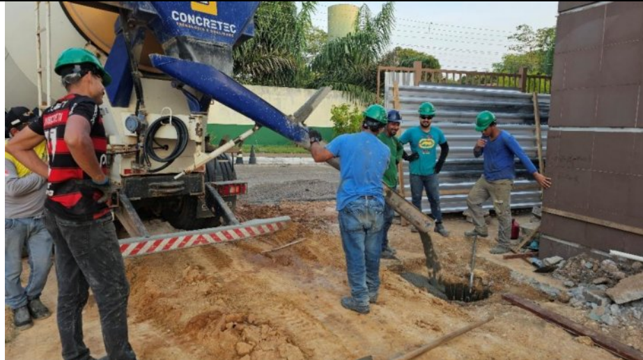
Visão geral do estacas da obra do Anexo 01 concretadas:
