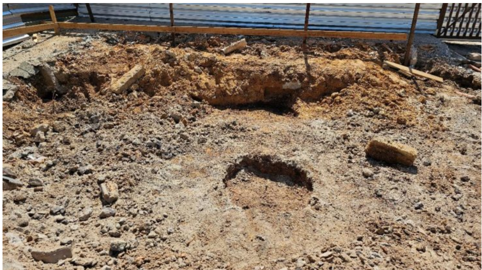
Demolição de concreto simples da calçada com martelete, onde será escavada as estacas ali locadas:
