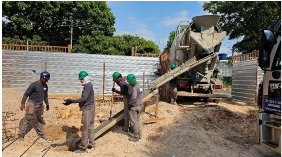
Concretagem e posicionamento das armações das estacas da obra do Anexo 02:
