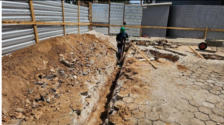
Desvio provisório da tubulação de esgoto existente do prédio para viabilizar a perfuração mecânica das estacas do Anexo 02:
