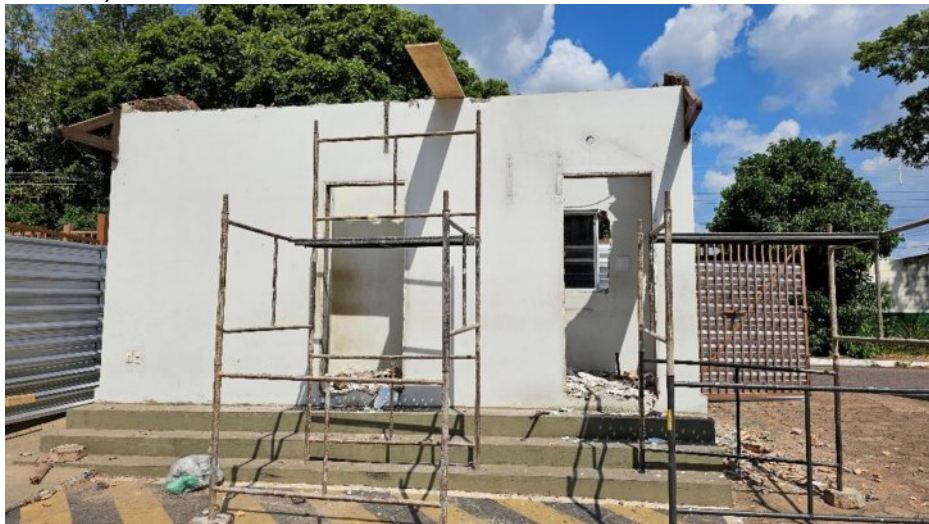
Continuação da armação das estacas do Anexo 01:
