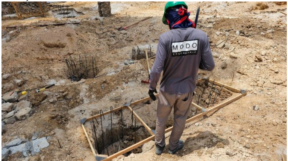
Escavação dos blocos de coroamento da obra do Anexo 02:
