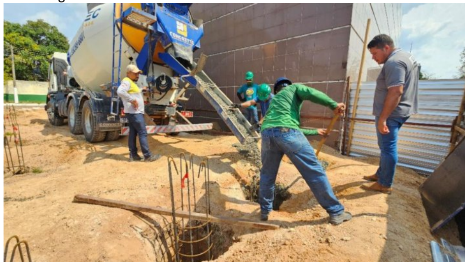
Concretagem das estacas da obra do Anexo 01:
