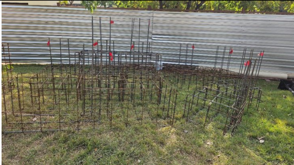
Início da armação das vigas baldrame da obra do Anexo 01:
