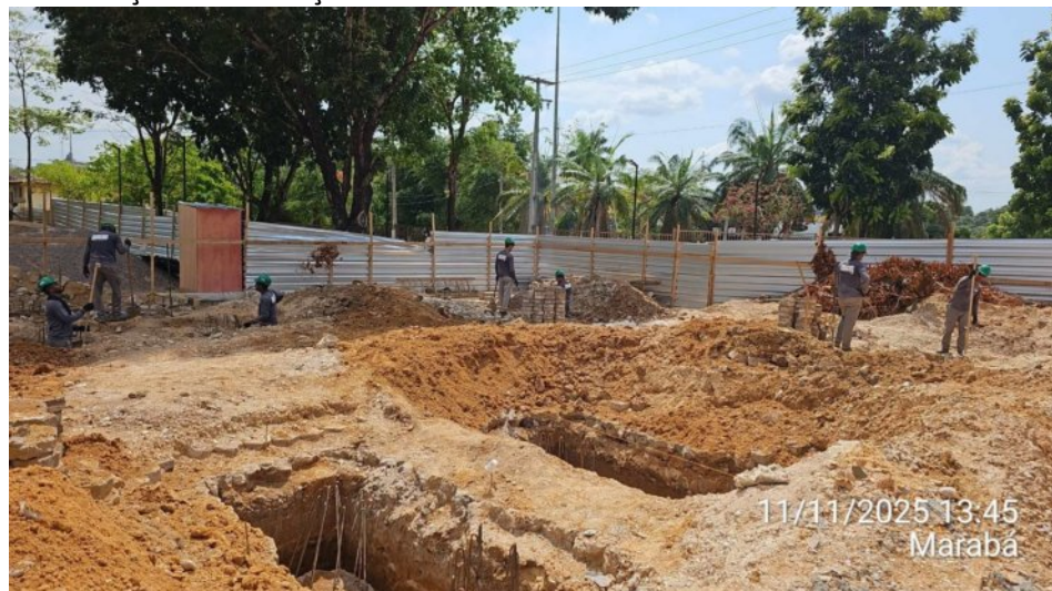
Continuação da escavação dos blocos de coroamento da obra do Anexo 02:
