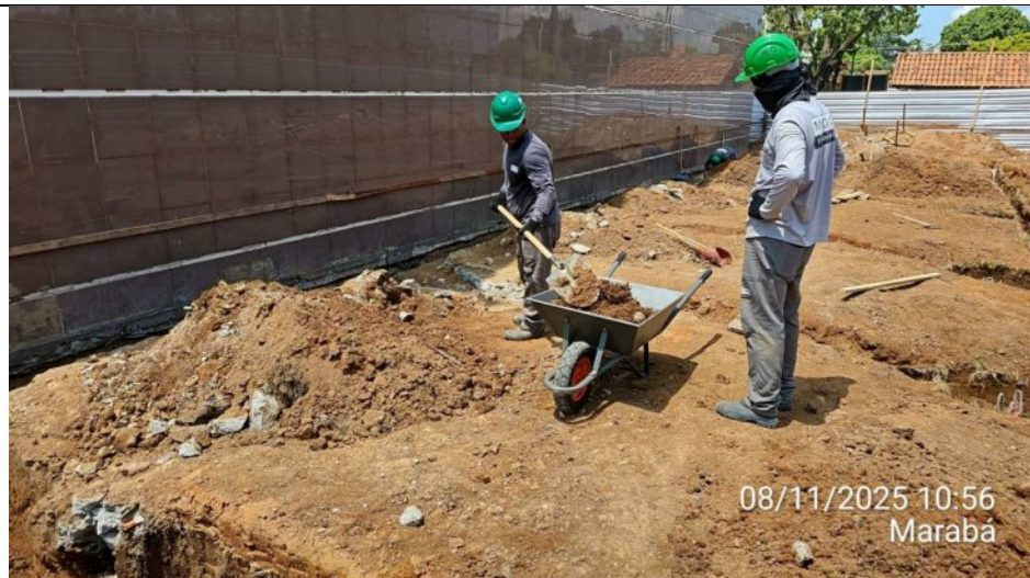
Continuação da escavação dos blocos do Anexo 02:
