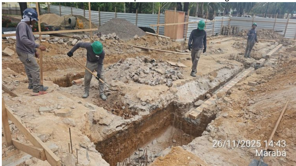
Assentamento de fiada de alvenaria para nivelar a base das vigas baldrame:
