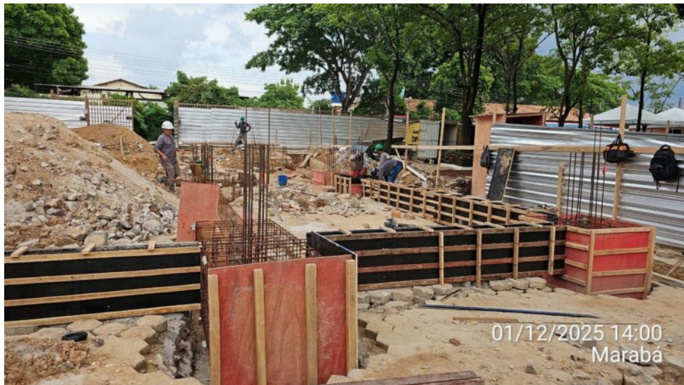
Posicionamento das fôrmas dos blocos e baldrame do Anexo 02:
