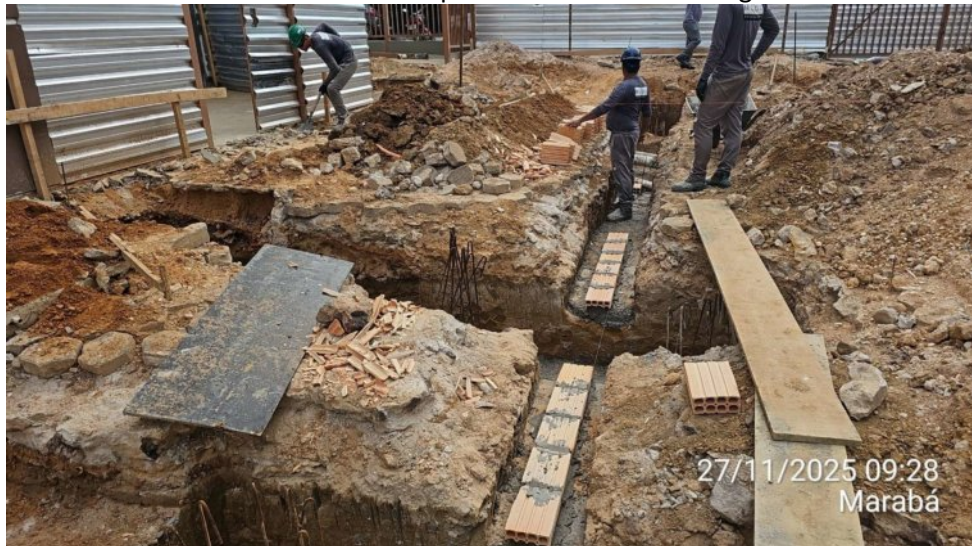
Assentamento de fiada de alvenaria para nivelar a base das vigas baldrame:
