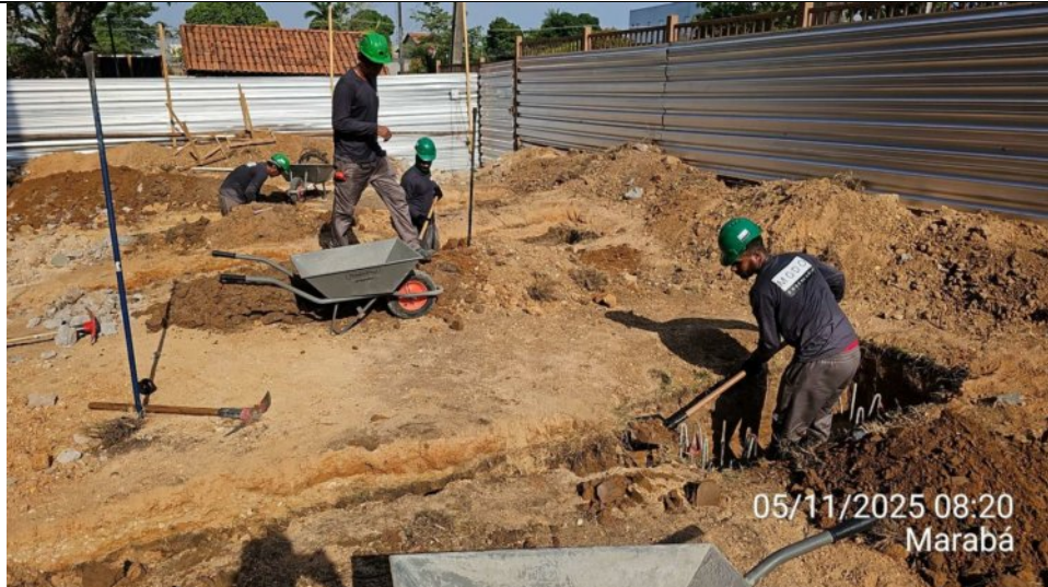
Escavação dos blocos de coroamento do Anexo 02:
