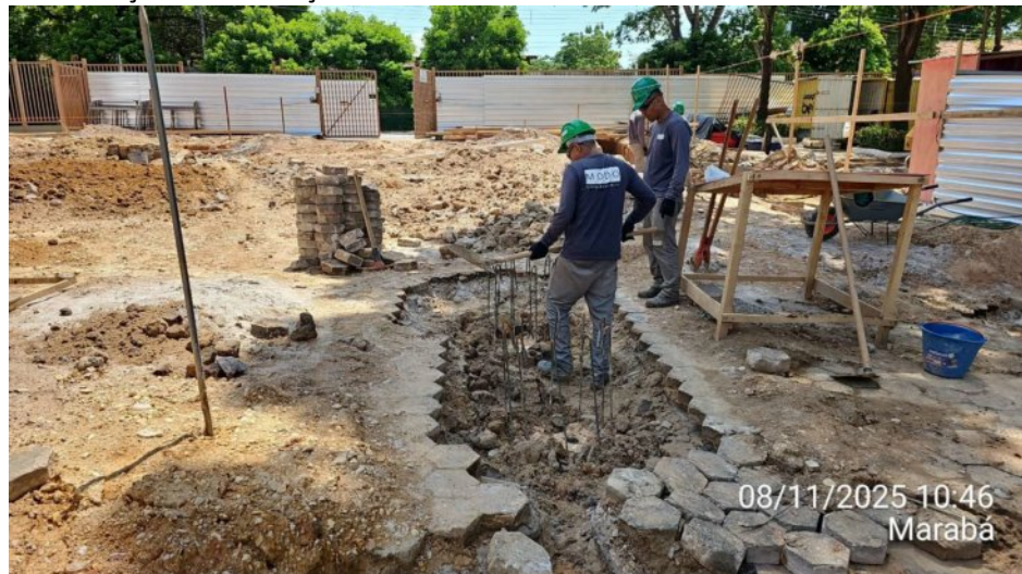
Continuação da escavação dos blocos do Anexo 02:
