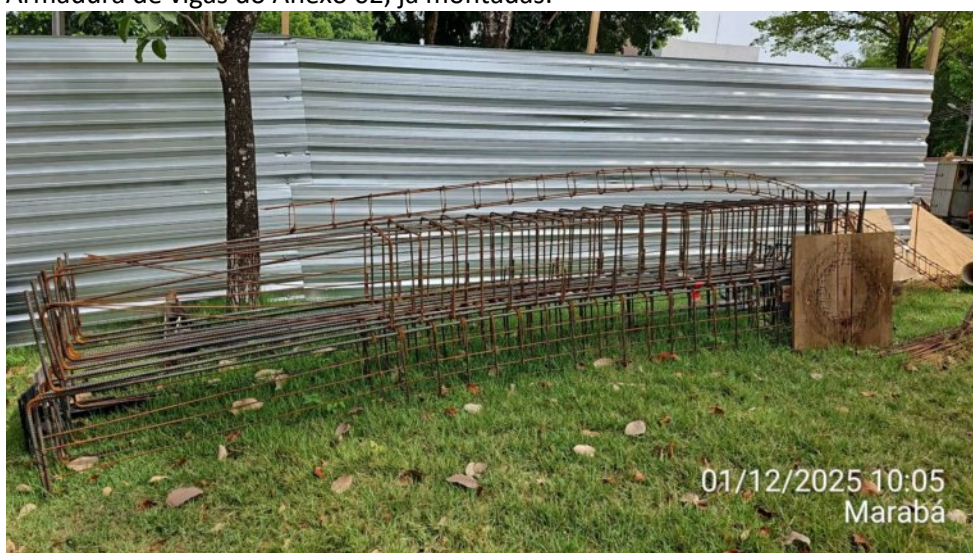
Armadura de vigas do Anexo 02, já montadas:
