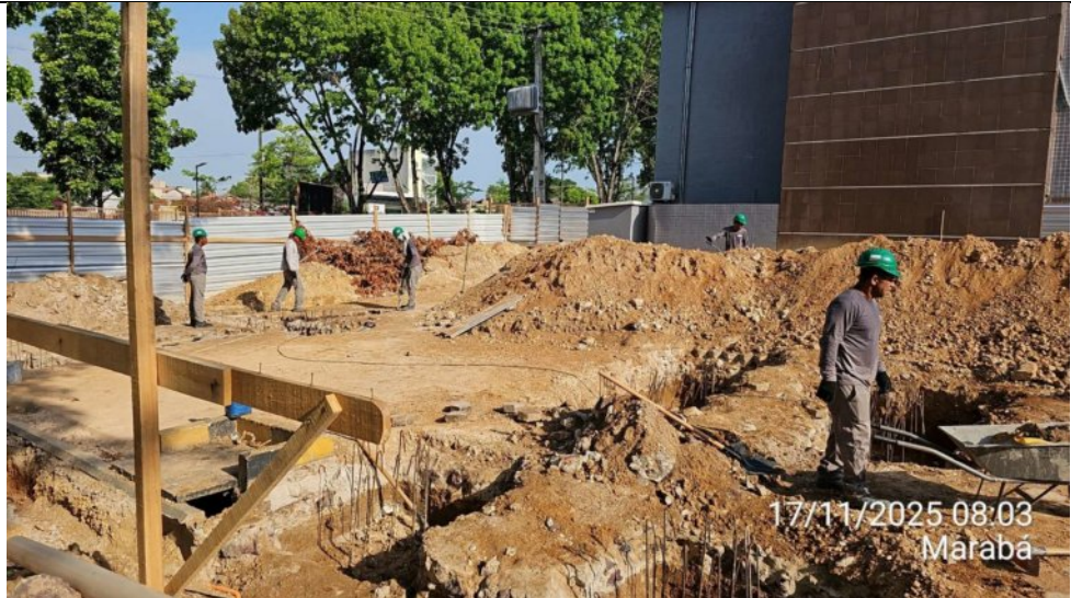
Retirada de bloquete sextavado do estacionamento e escavação das vigas baldrame da obra do Anexo 02:
