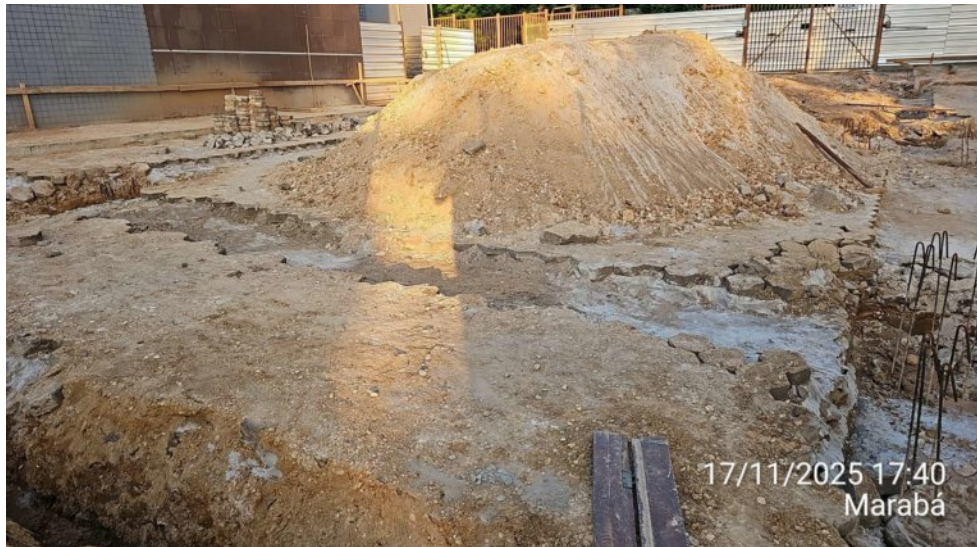
Retirada de bloquete sextavado do estacionamento e escavação das vigas baldrame da obra do Anexo 02:
