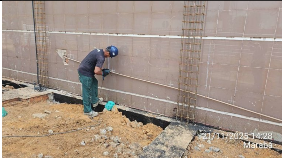
Escavação e aterramento para malha de cobre nu do sistema de proteção contra descargas atmosféricas:
