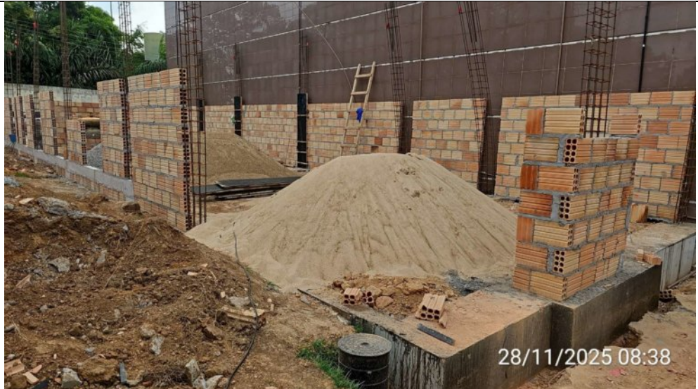
Retirada e entulho e bota-fora do Anexo 01:
