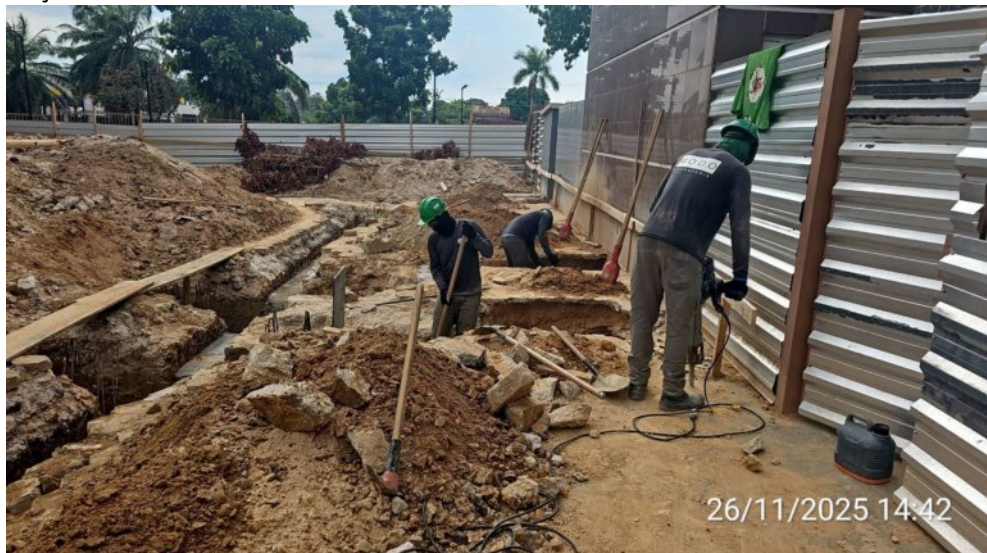
Continuação da escavação das vigas baldrame e blocos do Anexo 02 e demolição de calçada com martelete:
