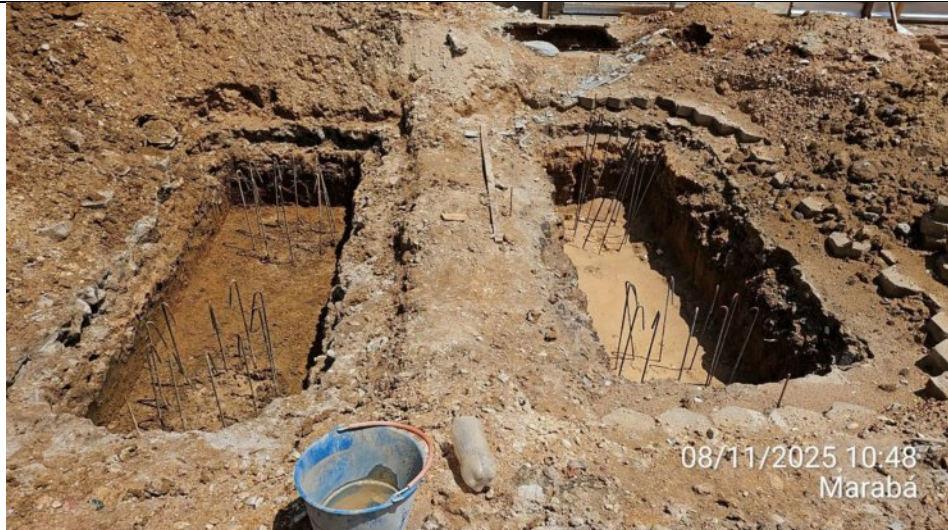
Montagem e fôrmas para vigas baldrame das obras:
