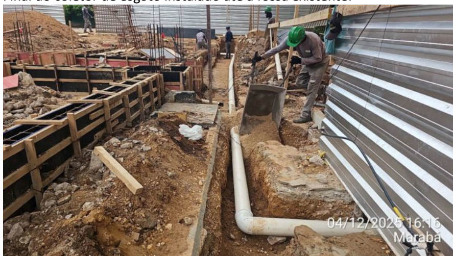
Final do coletor de esgoto instalado até à fossa existente:
