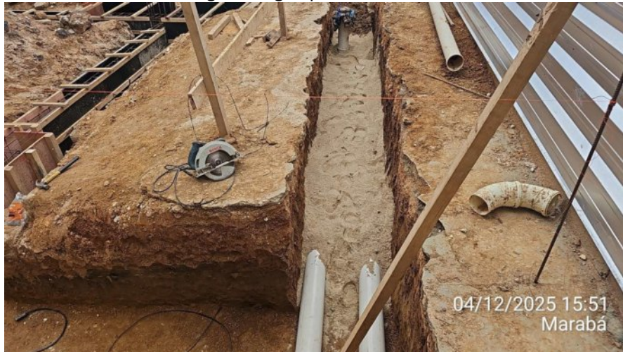
Reaterro das valas de esgoto e água pluvial:
