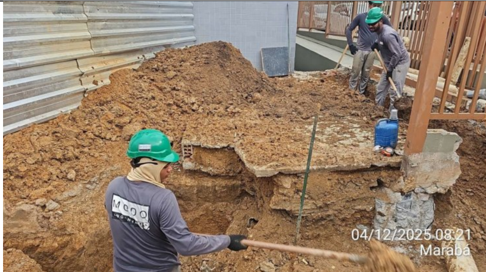
Retirada de entulho (bota-fora) do Anexo 02:
