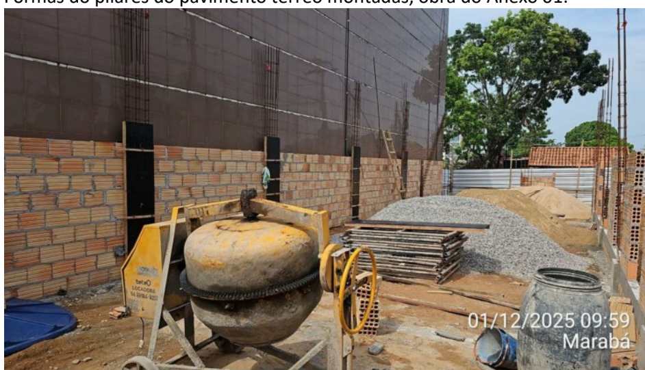
Fôrmas do pilares do pavimento térreo montadas, obra do Anexo 01:
