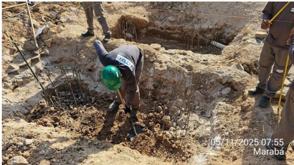
Escavação dos blocos de coroamento do Anexo 02:
