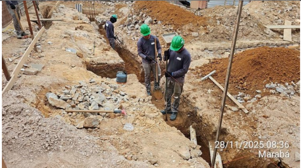
Assentamento de fiada de alvenaria para nivelar a base das vigas baldrame:
