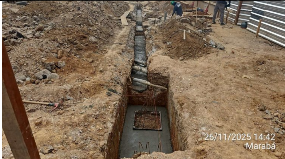
Continuação da escavação das vigas baldrame e blocos do Anexo 02 e demolição de calçada com martelete:
