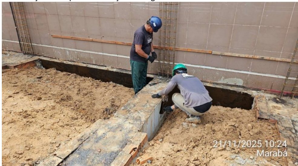
Continuação da impermeabilização das vigas baldrame do Anexo 01:
