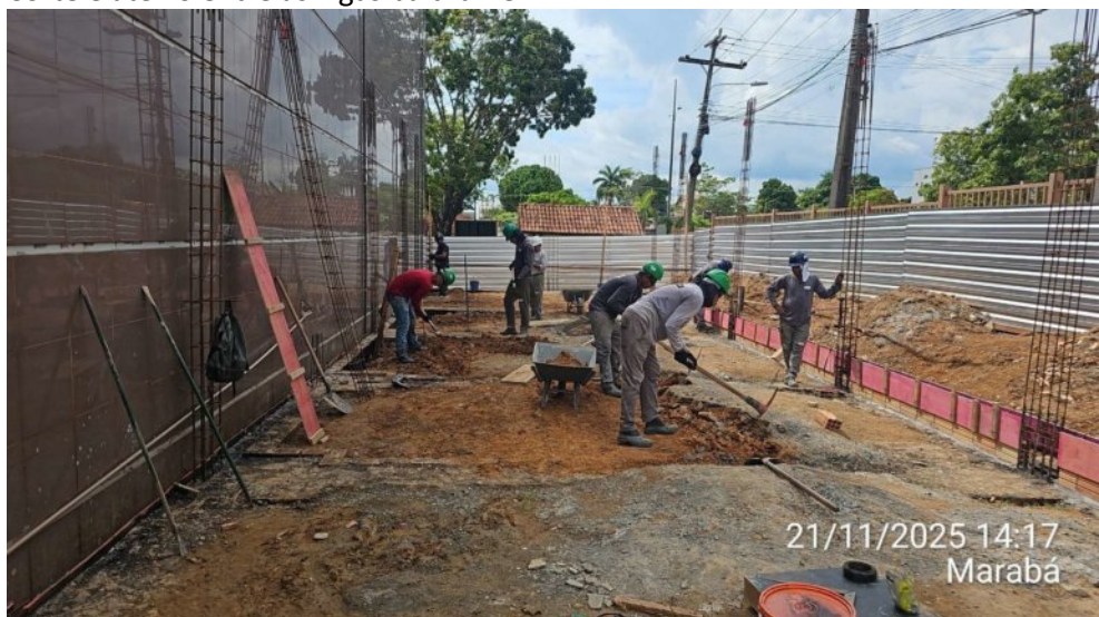
Corte e aterro entre as vigas baldrame:
