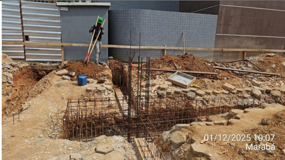
Posicionamento das fôrmas dos blocos e baldrame do Anexo 02:
