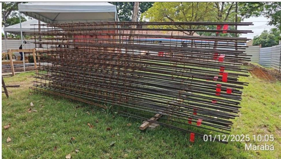
Armadura de vigas do Anexo 02, já montadas:
