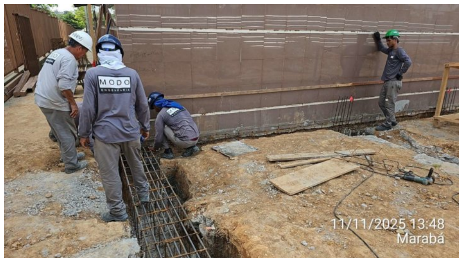
Continuação da retirada de entulho/bota-fora do Anexo 01:
