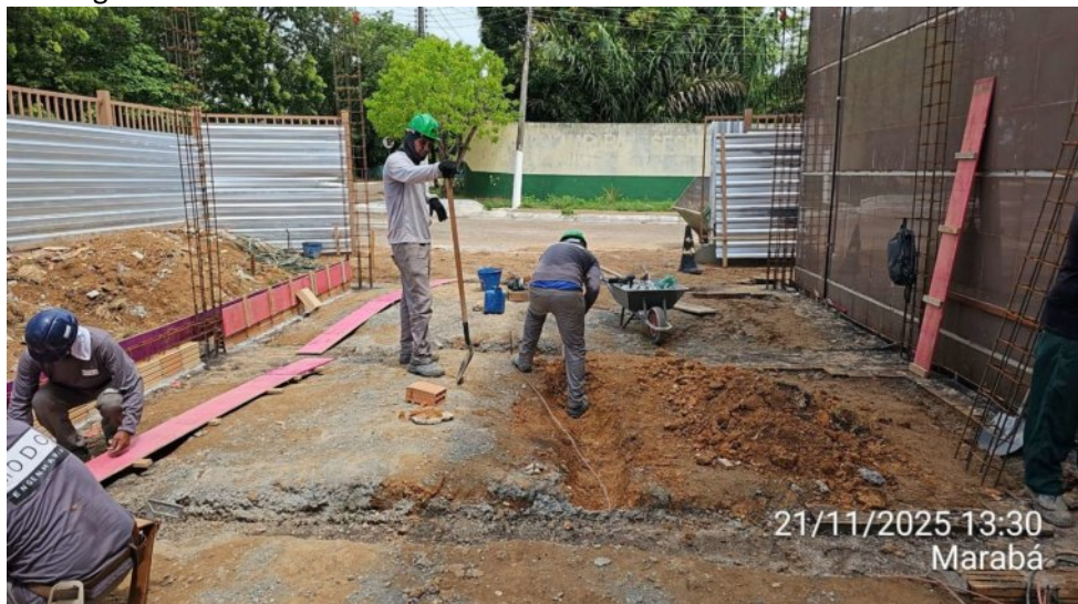
Escavação e aterramento para malha de cobre nu do sistema de proteção contra descargas atmosféricas:
