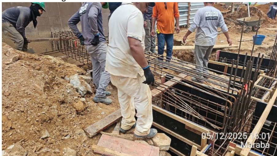
Armaduras de viga baldrame do Anexo 02:
