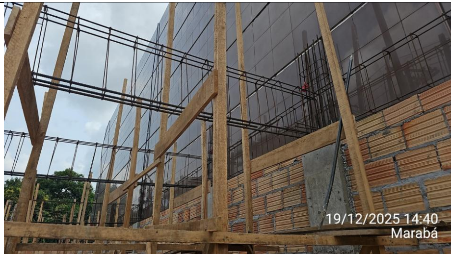
Anexo 02 – Concretagem dos pilares do pavimento inferior (estacionamento) com lançamento e adensamento:
