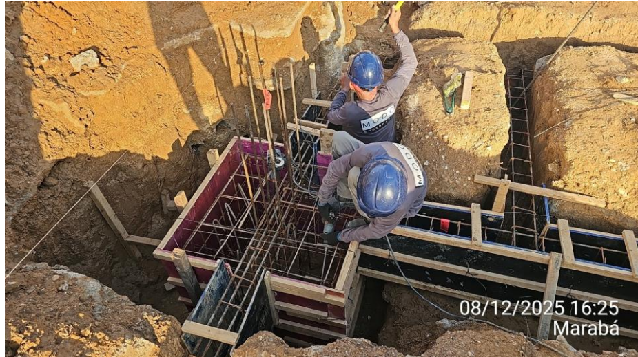
Amarração de fôrmas:
