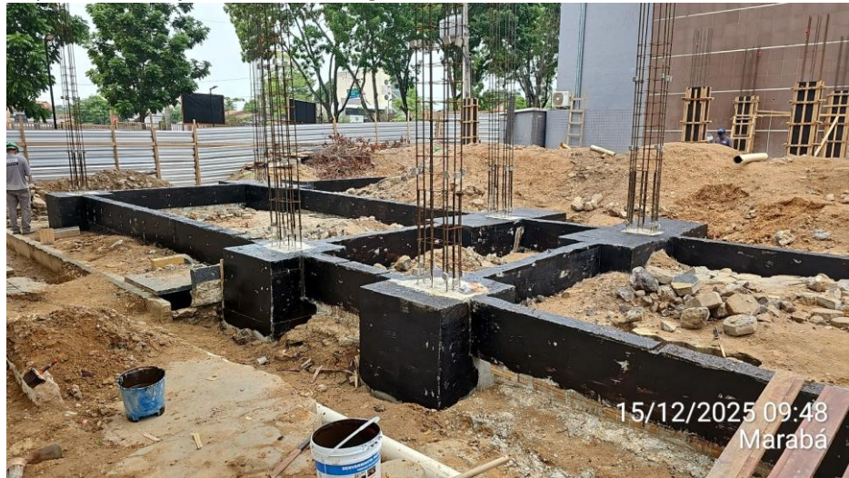
Impermeabilização de blocos e vigas baldrame do Anexo 02:
