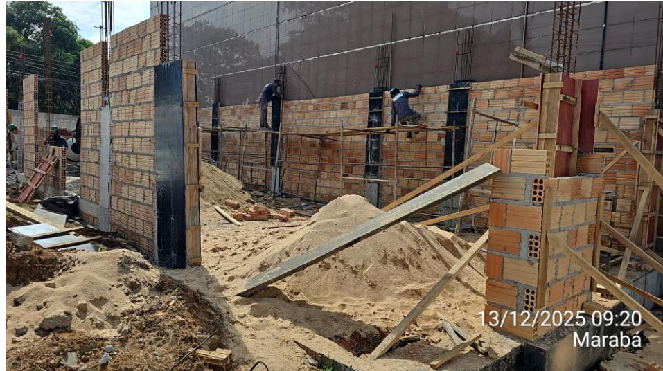
Visão geral da obra do Anexo 01:
