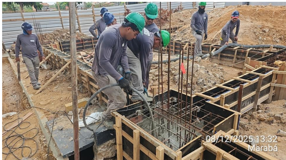
Lançamento e adensamento de concreto:
