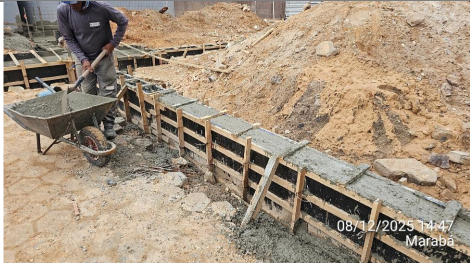
Adensamento de concreto:
