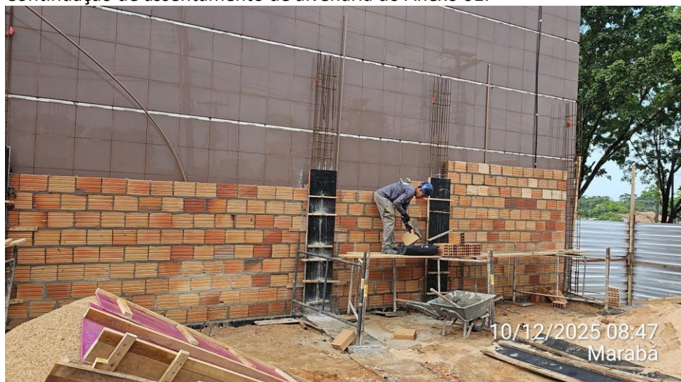
Continuação de assentamento de alvenaria do Anexo 01:
