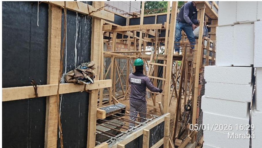
Anexo 01 – Concretagem de vigas de apoio de patamares intermediários da escada:
