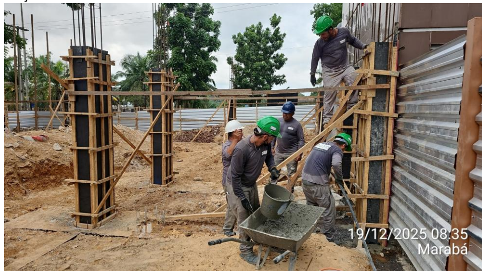
Anexo 02 – Concretagem dos pilares do pavimento inferior (estacionamento) com lançamento e adensamento:
