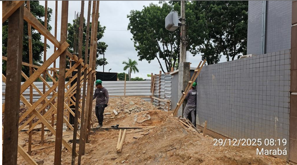
Anexo 01 – Colocação dos fundos de viga (fôrmas) das vigas superiores:
