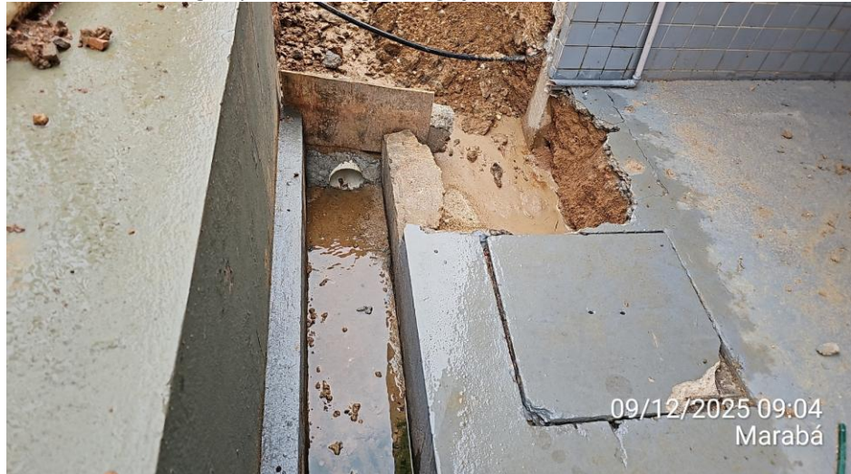
Novos tubos de água pluvial e esgoto, ligação com prédio existente:
