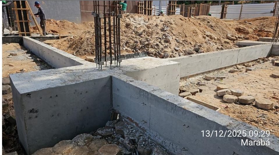
Superfície de bloco de coroamento do Anexo 02, mostrando o resultado do adensamento:
