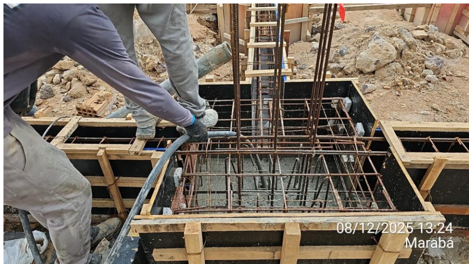
Adensamento de concreto:
