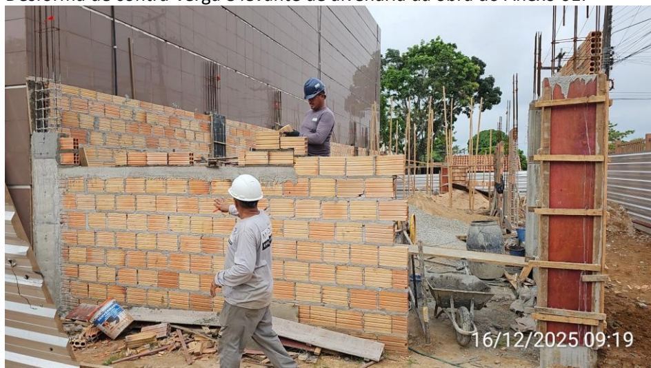
Desforma de contra-verga e levante de alvenaria da obra do Anexo 01:
