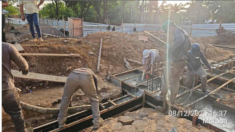
Visão geral de vigas e blocos concretados:
