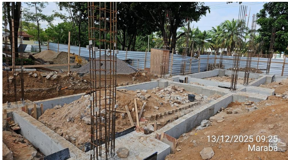
Baldrame desformatado do Anexo 02:
