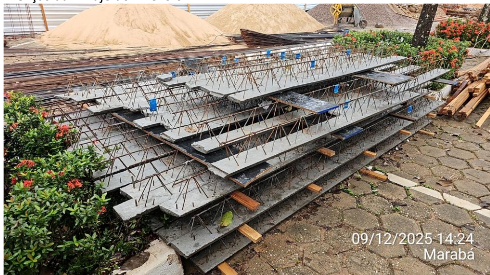
Treliças da 1ª laje do Anexo 01:
