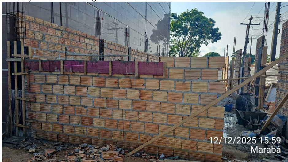
Confecção de contra-verga moldada in loco:
