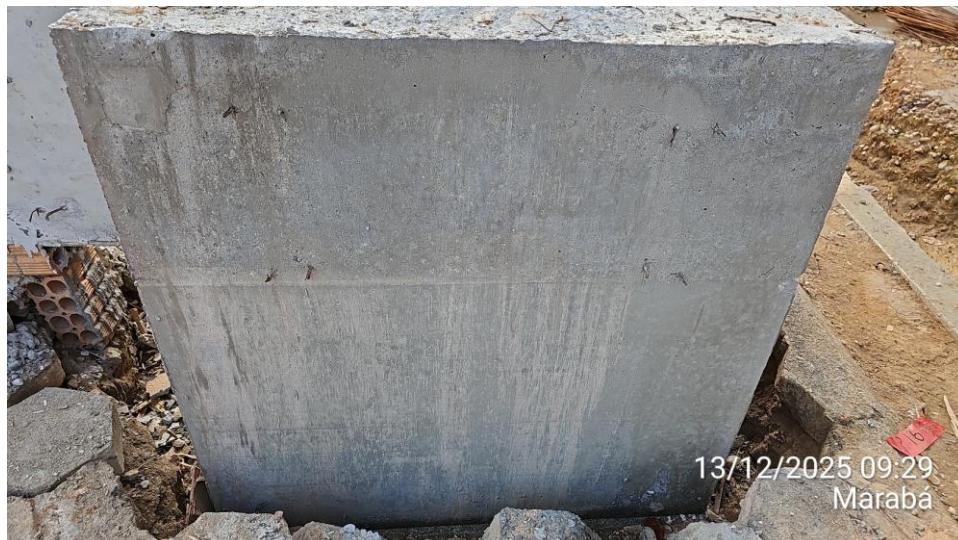
Superfície de bloco de coroamento do Anexo 02, mostrando o resultado do adensamento:
