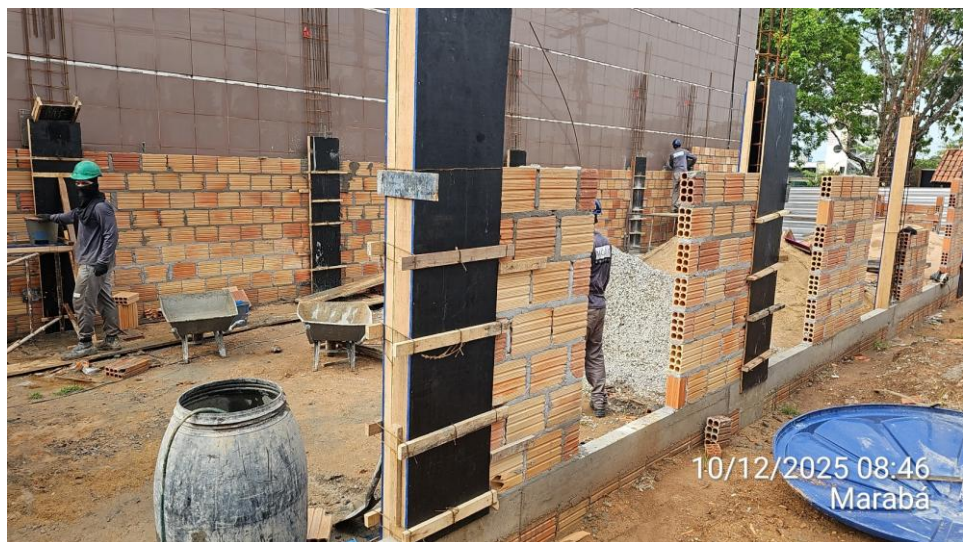
Continuação de assentamento de alvenaria do Anexo 01:
