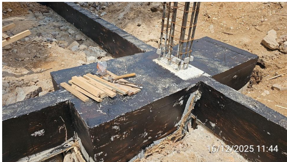
Desforma de contra-verga e levante de alvenaria da obra do Anexo 01:
