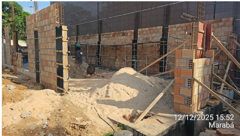
Continuação da alvenaria da obra do Anexo 01:
