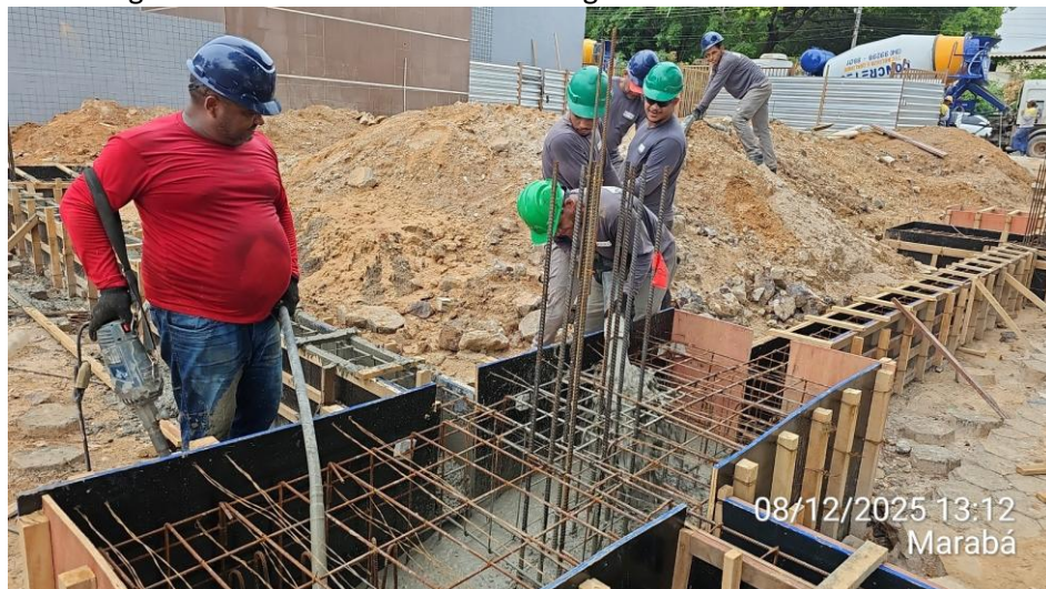
Concretagem de blocos de coroamento e vigas baldrame:
