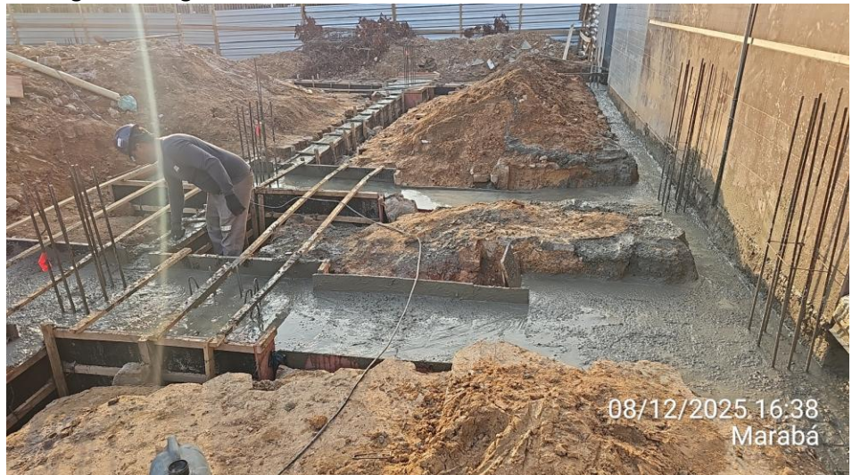
Visão geral de vigas e blocos concretados:
