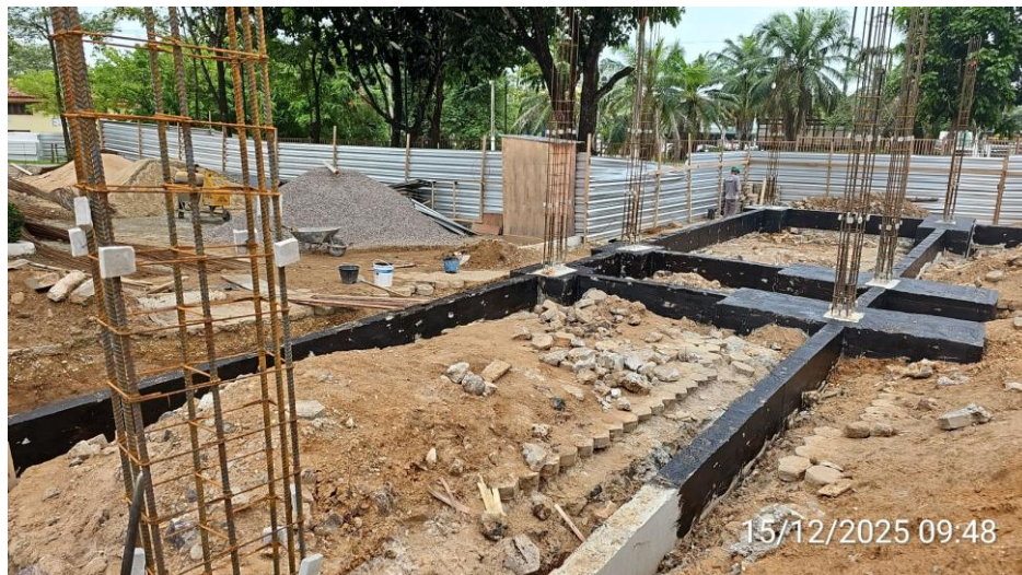
Desforma de pilares da obra do Anexo 01:
